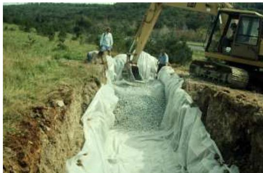
**Figura 2.8** Ejemplo de un sistema de tratamiento pasivo (Skousen, 2000).
