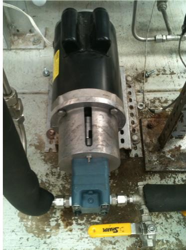
Figura 3.8: Bomba y motor empleados para circular la solución del absorbedor al generador.
