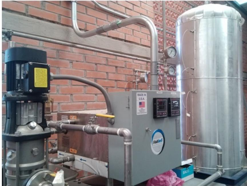
Figura 3.14: Fotografía del sistema comercial utilizado para controlar la temperatura de generación durante la evaluación
