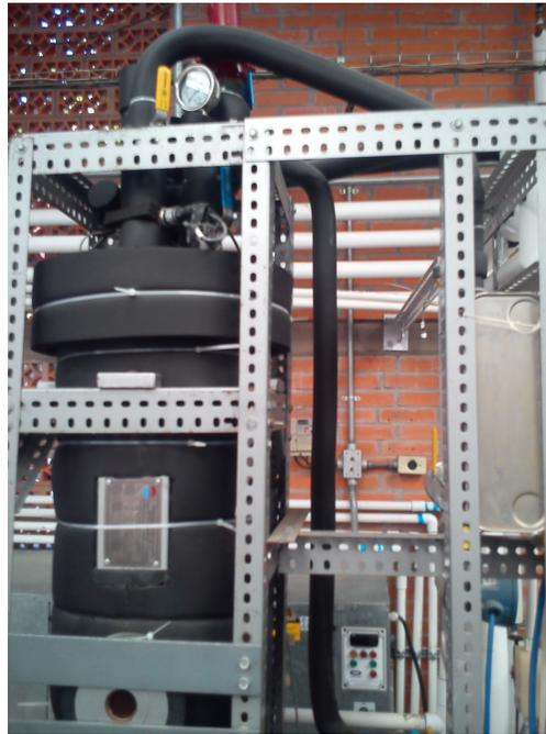
Figura 3.12: Fotografía del generador y líneas de conducción aisladas térmicamente
