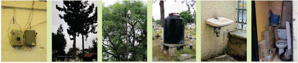
Fotos 37-42.-Infraestructura en las instalaciones del cementerio 2
