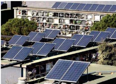
Imagen 38.- Celdas solares sobre los nichos 22
