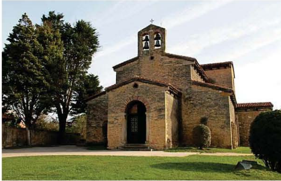
Imagen 33.- Fachada Principal de San Julián 18
