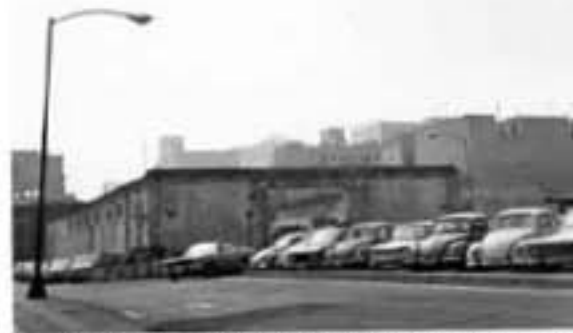
18. Vista del estacionamiento que posteriormente se convertiría en la Plaza de las Vizcainas
