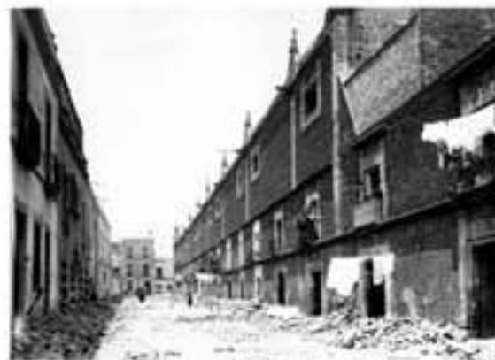
11. Daños ocasionados por el terremoto de 1985.
