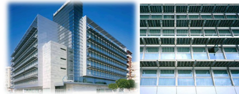
Imagen de la fachada sur con los paneles fotovoltaicos como parte-soles, imagen extraída de la página web del despacho, Hombre de Piedra 7
