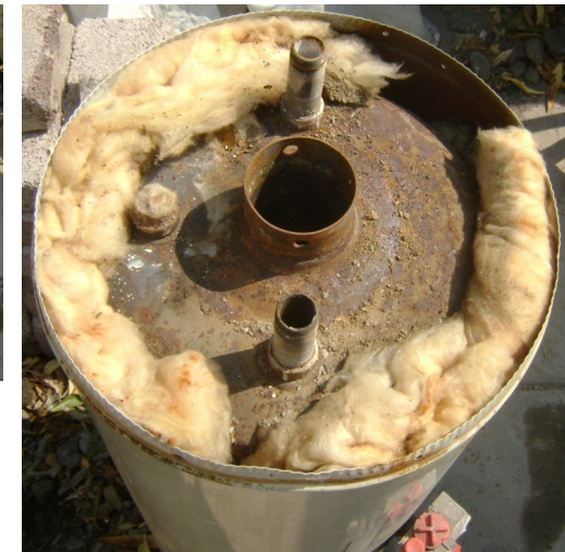
Imágenes donde se muestra, (Izq.) calentador de agua con tapa y capuchón. (Der) interior del calentador en la parte central esta hueco como una dona para que pase la flama y caliente el agua a través de la lamina del contenedor interior la lana mineral y la cubierta exterior aíslan del exterior para evitar pérdidas de temperatura, imagen tomada por el autor. © Daniel E García Flores.
