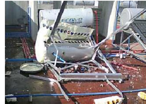
Imagen tomada con fines didácticos, del Universal, Estado de Mexico, donde se muestra los restos de un calentador solar después que explota por falta de agua en el conjunto de "ecoviviendas" San Francisco Bungalows, en Cuautitlán Izcalli.
