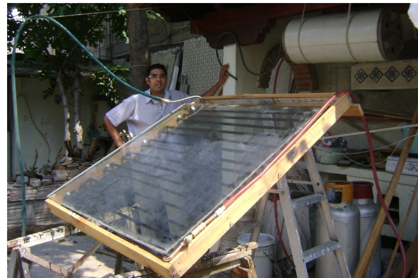
Imagen donde se observa el montaje del sistema para su revisión de funcionamiento de flujo. © Daniel E. García Flores.
