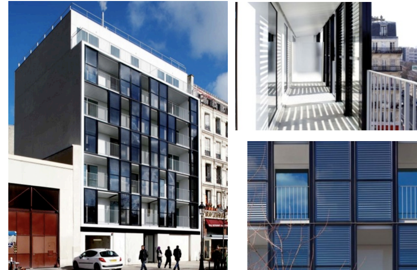
Imagenes tomadas de: http://www.dforcesolar.com/energia-solar/paris-tiene-su-primero-edificio-de-interes-social-con-energia-solar/ , los autores del proyecto son Philippon-Kalt Architects
