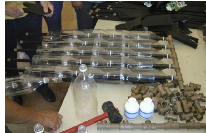
Imagen tomada de ecocosas.com con fines didácticos, donde se muestra la tubería de plástico, envuelta con tiras de cartón de las cajas tetrapak pintadas de negro, también se observa que las botellas han sido rebanadas por su base y se insertan en cada columna de la tubería.
