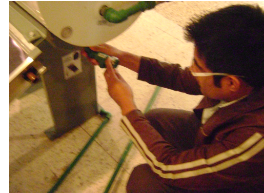
Imagen en donde el autor realiza una instalación con tuboplus para un calentador solar con termotanque © Daniel E García Flores.
