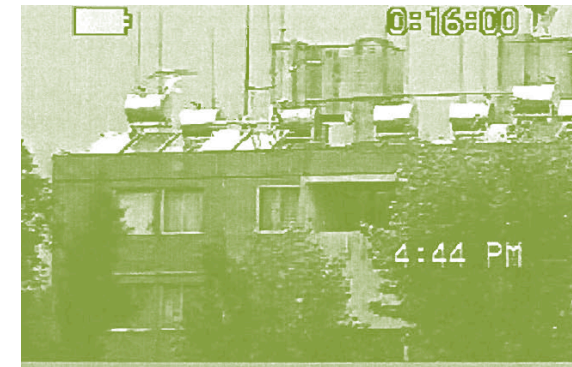
Imagen tomada por Edgar León Cacho, panorámica general de los calentadores solares
