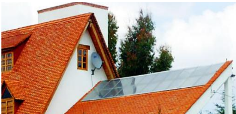
Figura 2.15. Instalación de un calentador solar incorporado en la edificación de la vivienda. 1
