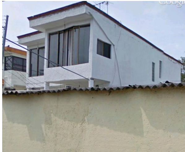
Figura 5.1. Estado actual de la vivienda. 1
