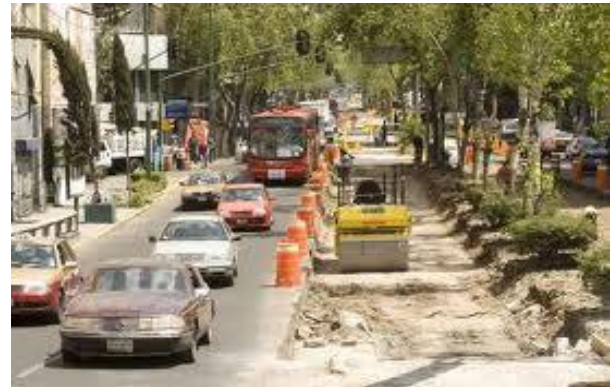
Imagen 3.3.5 Sustitución de la carpeta asfáltica por concreto hidráulica en Av. Insurgentes
