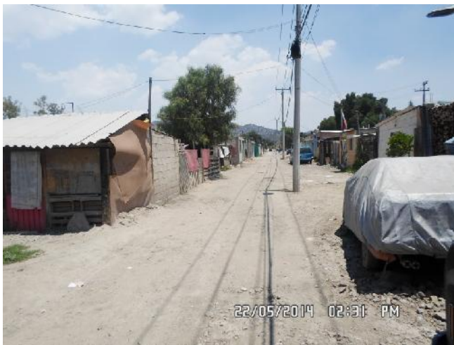
Foto 3.- Calle principal de La Nueva Suburbana. Se observa la nula pavimentación de la calle.
