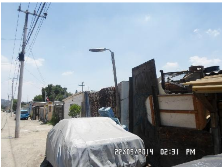
Foto 4.- Se observa que no existe alumbrado público, cada casa alumbró su entrada
