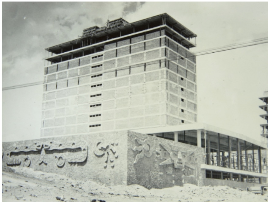
Fuente: Archivo DGOyC. Construcción Biblioteca Central.
