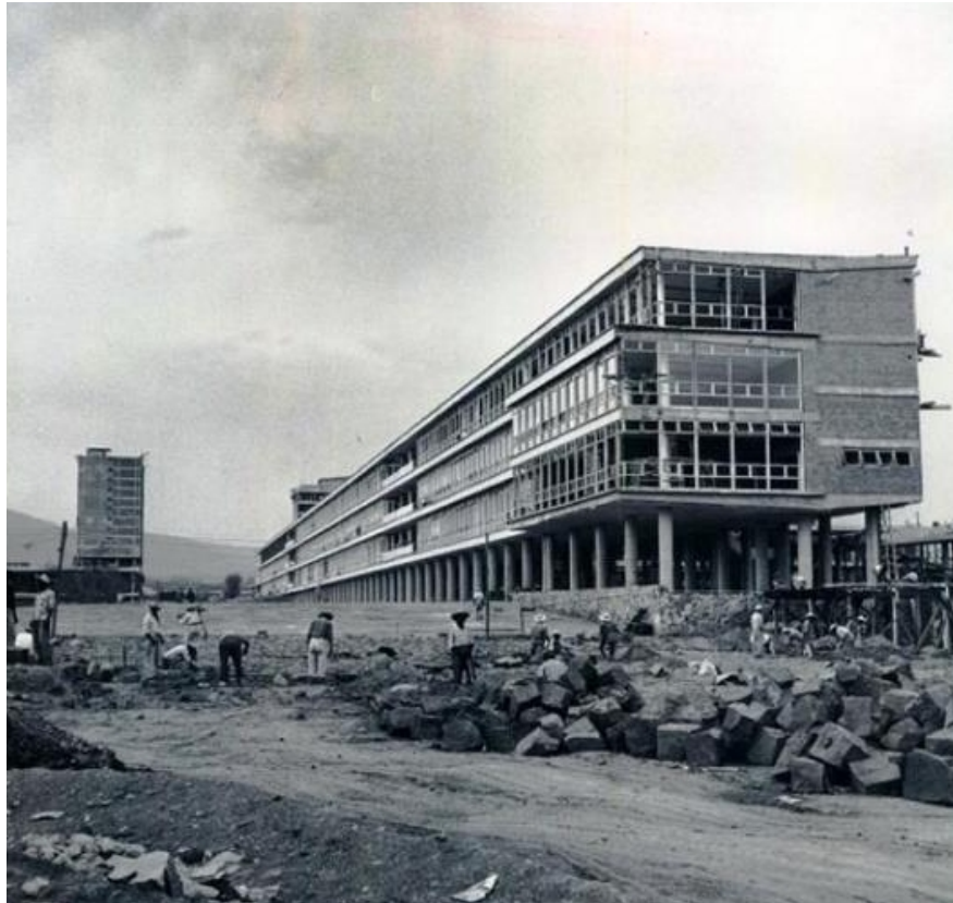
Fuente: Archivo DGOyC. Construcción Facultad de Economía.
