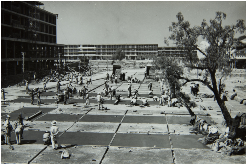
Fuente: Archivo DGOyC. Construcción Explanada Facultad de Ingeniería.
