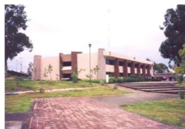
EDIFICIO DE DIVISIÓN ACADÉMICA
