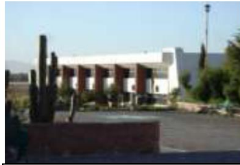
ELECTRÓNICA, ADMINISTR. Y AUTOMATIZACIÓN
