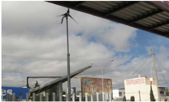
Figura 18. Sistema híbrido ubicado entre Río las Avenidas y Jaime Nuno Fuente: Tomada por Cristina Olmedo Santiago, 2014.
