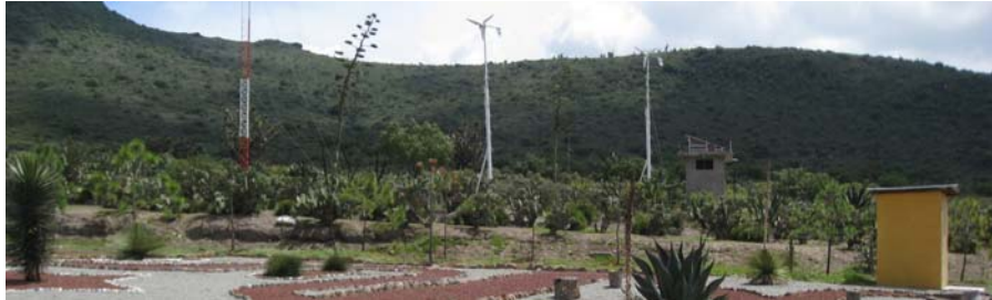
Figura 21. Aerogeneradores ubicados en el Parque Ecológico Cubitos Fuente: Tomada por Cristina Olmedo Santiago, 2014
