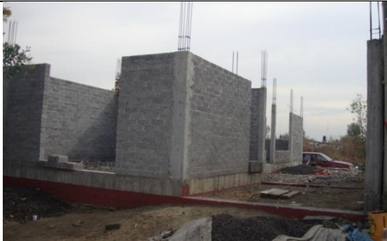
FOTO: Proceso de Construcción en el Asentamiento Ampliación La Conchita
