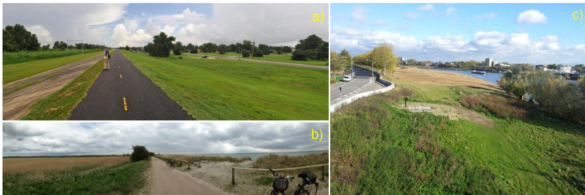
Figura 6.12 a) bordo de protección con una vía en la corona, b) ciclopista entre el cuerpo de agua (a la derecha del camino) y una zona de amortiguamiento (a la izquierda del camino), c) zona de amortiguamiento entre el cuerpo de agua e infraestructura vial
