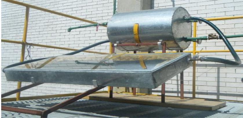
Figura 3.h Instalación completa del calentador.
