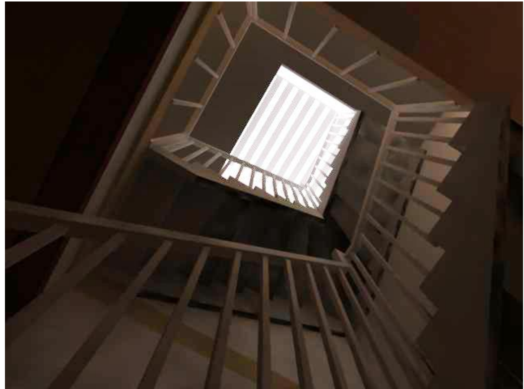
Vista de cubo de escaleras
