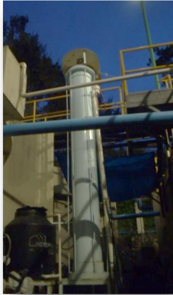
a. Reactor tipo UASB
