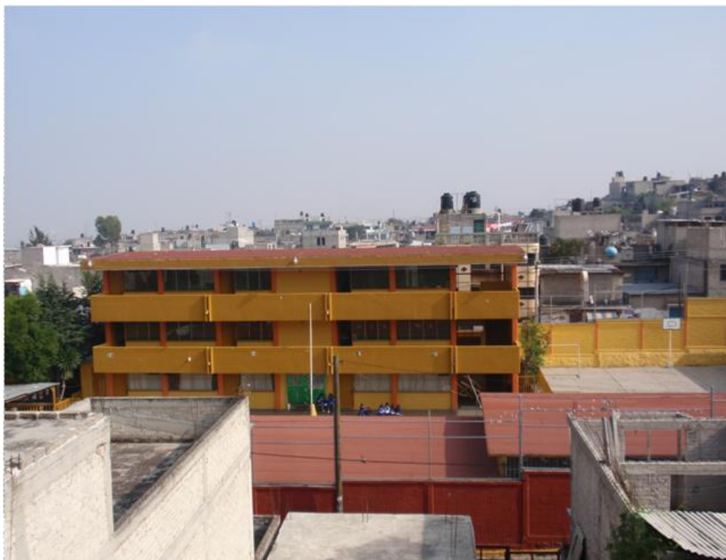
Figura 6. La escuela en donde se realizaron las prácticas. Al fondo, se observan las condiciones del terreno.
