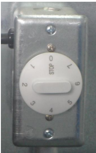
Figura 5. Termostato de la cámara de congelación.
