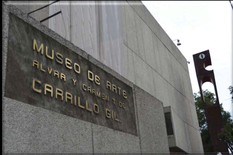
2.21 Intervención en la estructura arquitectónica del Museo de Arte Carrillo Gil
