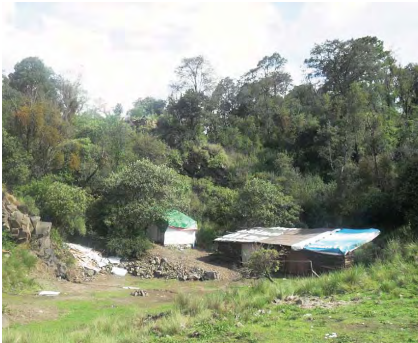
Fig. 24 Fotografía del predio ubicado en la localidad rural Los Tlapancos.
