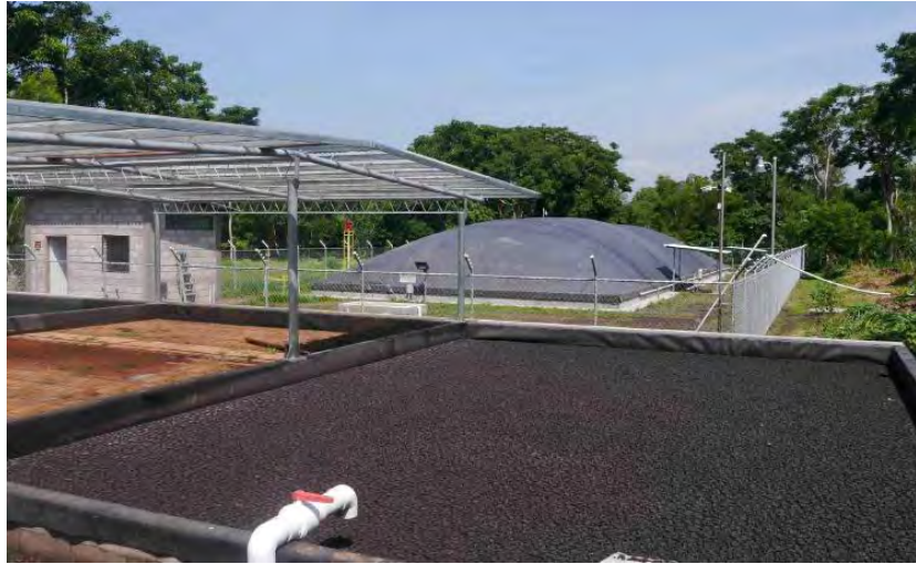
Figura 5.7. Vista panorámica del lecho de secado de lodo.
