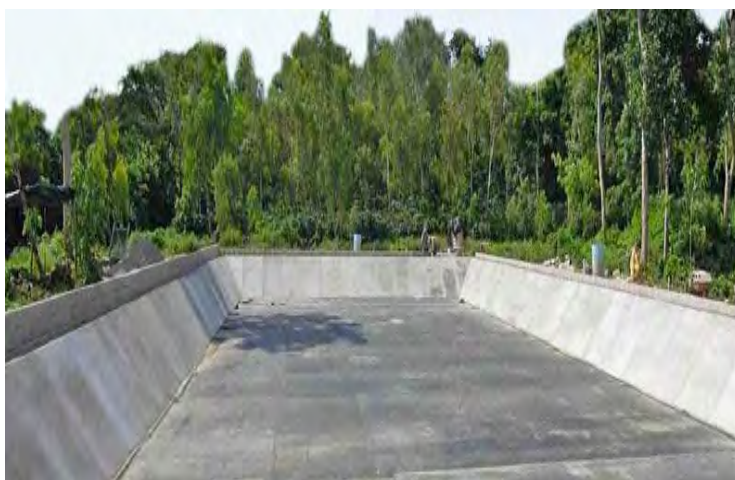
Figura 5.6. Vista lateral del tanque de descarga vacío.
