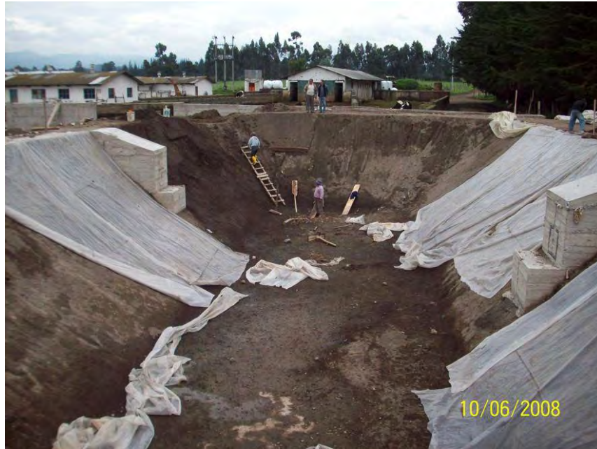
Figura 5.2. Construcción de la estructura del biodigestor tipo laguna.
