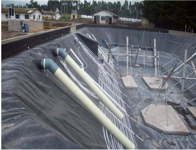
Figura 5.4. Colocación de equipos auxiliares al interior de la laguna.
