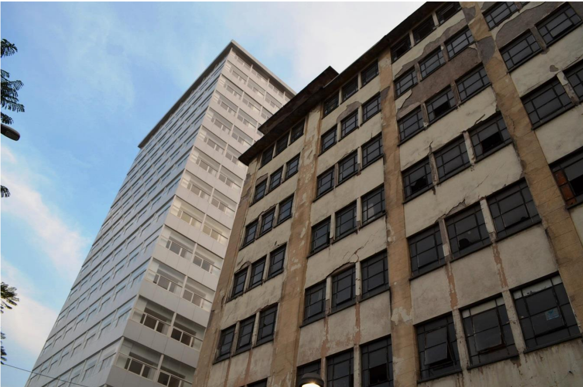
Foto 9. Hotel Bamer y edificio abandonado
