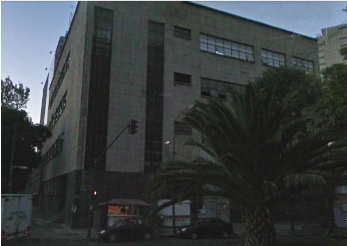
Edificio de la Dirección Federal de Seguridad. En su sótano se encontraba una cárcel clandestina y un cuarto para torturar. Fuente: http://misteriosinmisericordia.noblogs.org/
