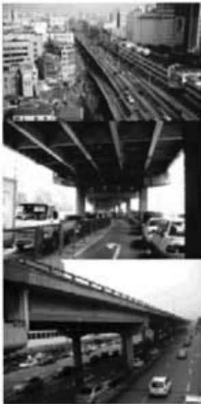
Imágenes del funcionamiento de la autopista antes de ser demolida
