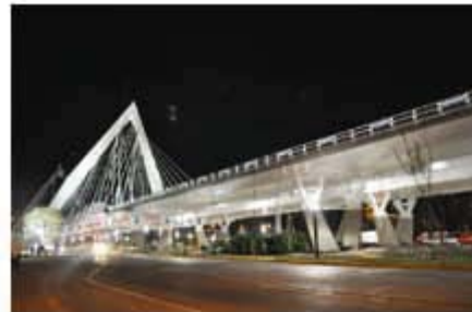
PUENTE ATIRANTADO , Viaducto Atirantado Guadalajara , Mexico.
