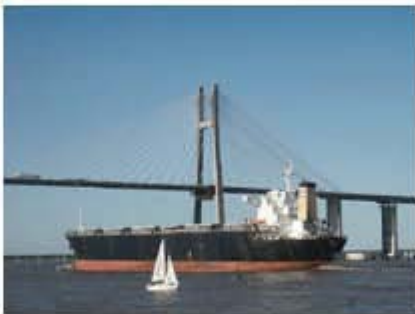
PUENTE EN MENSULA Puente Rosario-Victoria El Rosario Argentina.
