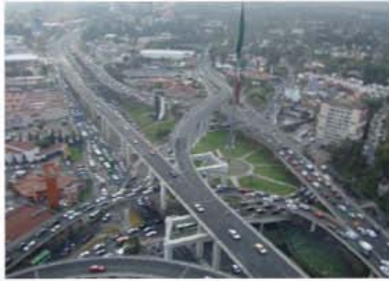
PASO A DESNIVEL. San Jeronimo DF, México.
