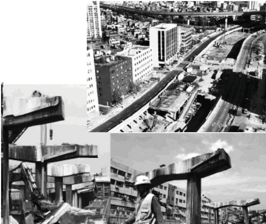
La demolición de la autopista comenzó en Julio de 2003.
