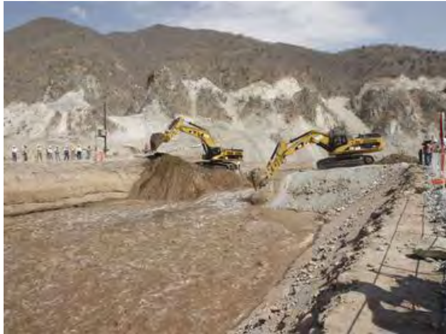
Trabajos previos construcción del camino de acceso
