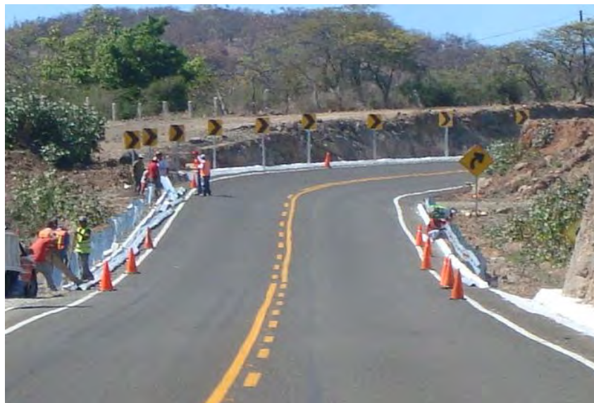
Colocación de defensa metálicas
