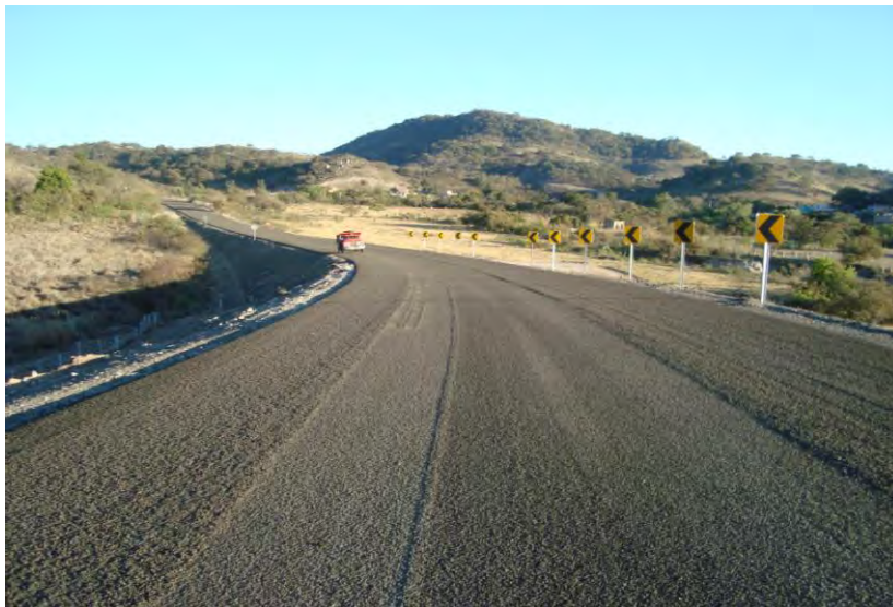
Colocación de carpeta y señalamiento preventivo
