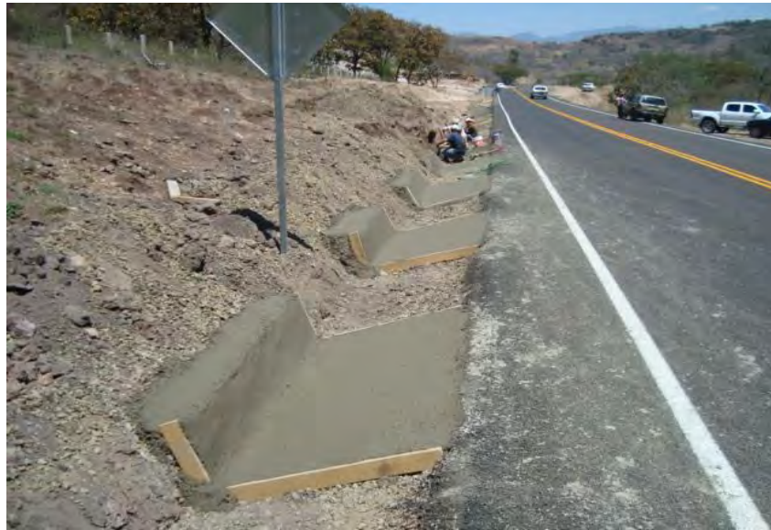
Construcción de guarniciones
