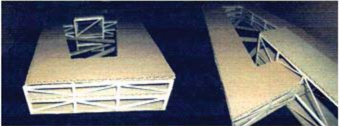
FIGURA 148. Vista de la losa hueca pretensada, traveses y columnas del edificio C.
