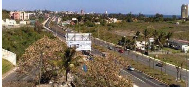
FIGURA 60. Vista aérea de la localización del predio de proyecto
