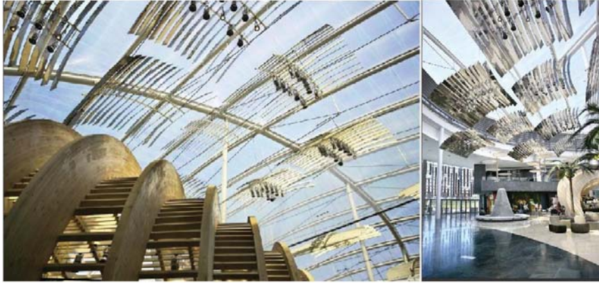
FIGURA 38. Cubierta transparente EFTE, innovación del Centro Comercial Islazul
