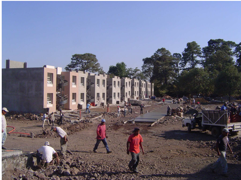
Anexo "D" El proceso de colado consiste en preparar y terminar la mitad longitudinal de la calle y posteriormente la otra mitad.
