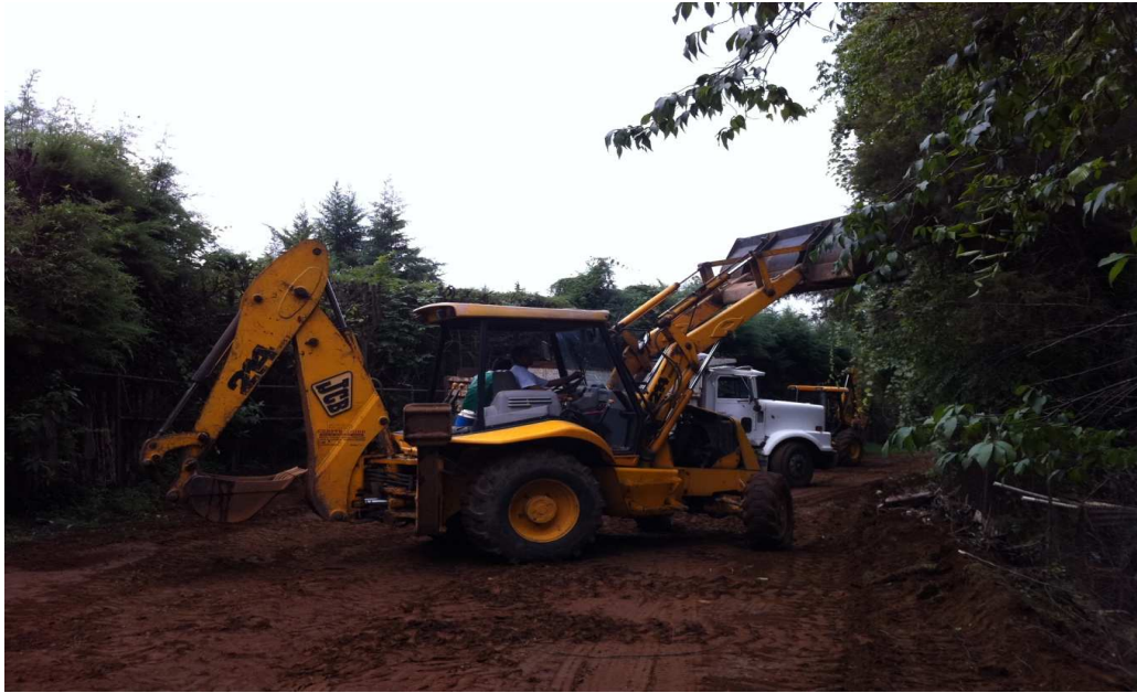
Foto 3.7. Abriendo caja para recibir el filtro y la base hidráulica.
