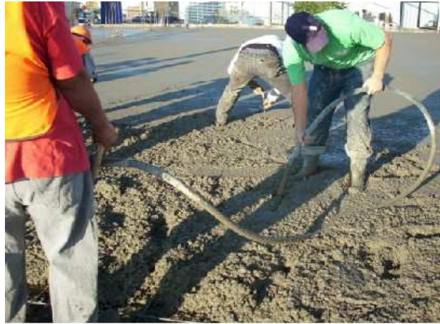
Figura 5.8. Vibrado en concreto hidráulico.
