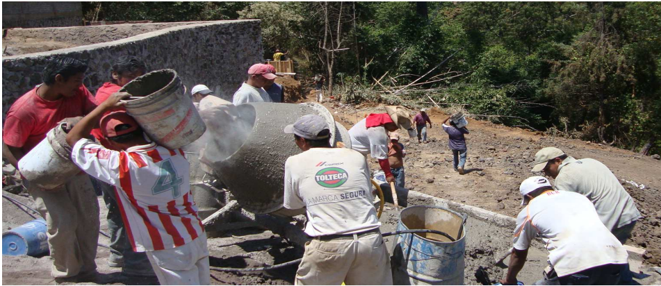
Figura 5.5. Elaboración de concreto en obra.
