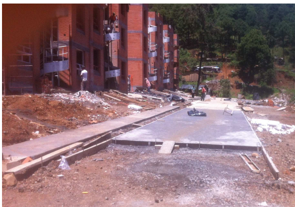
Figura 5.6. Pavimentación en proceso
