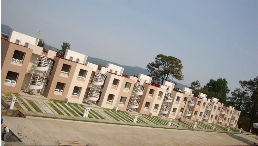
Anexo "E" Primera etapa terminada.
