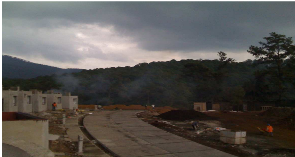
Foto 3.11. Colado de pavimento.
