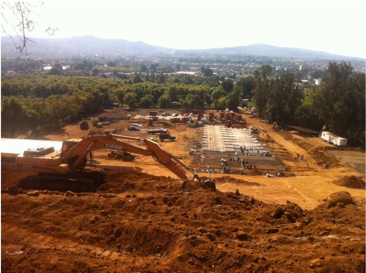
Foto 3.9. Avance constructivo del proyecto.
