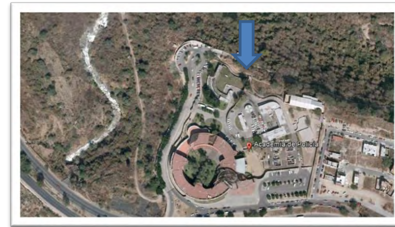
Vista aérea del conjunto.
