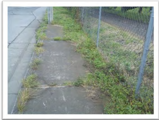
Podemos observar la colindancia que se tiene del terreno con la calle Eucalipto y la banqueta.
