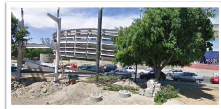
Vista lateral del edificio.
