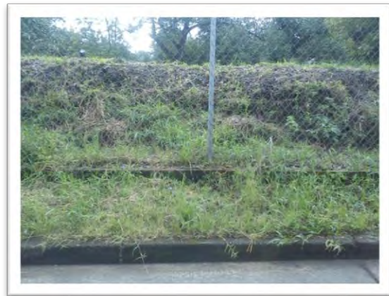
Podemos observar el desnivel que tiene el terreno en la superficie de rodamiento se elevó el nivel y se mejoró con tierra, grava y se le agregó una capa de asfalto para la circulación de vehículos del aeropuerto que recorren las colindancias del terreno.
