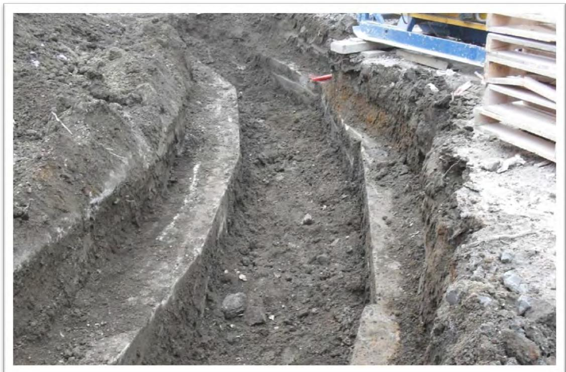
*Fig. 22 Brocales terminados para excavación de muro primario*
