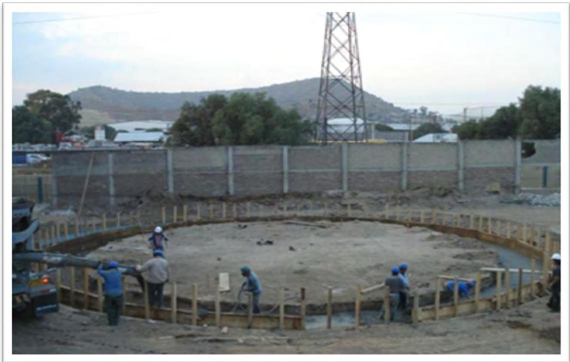
Fig. 26 Muro Primario con lodo fraguante
