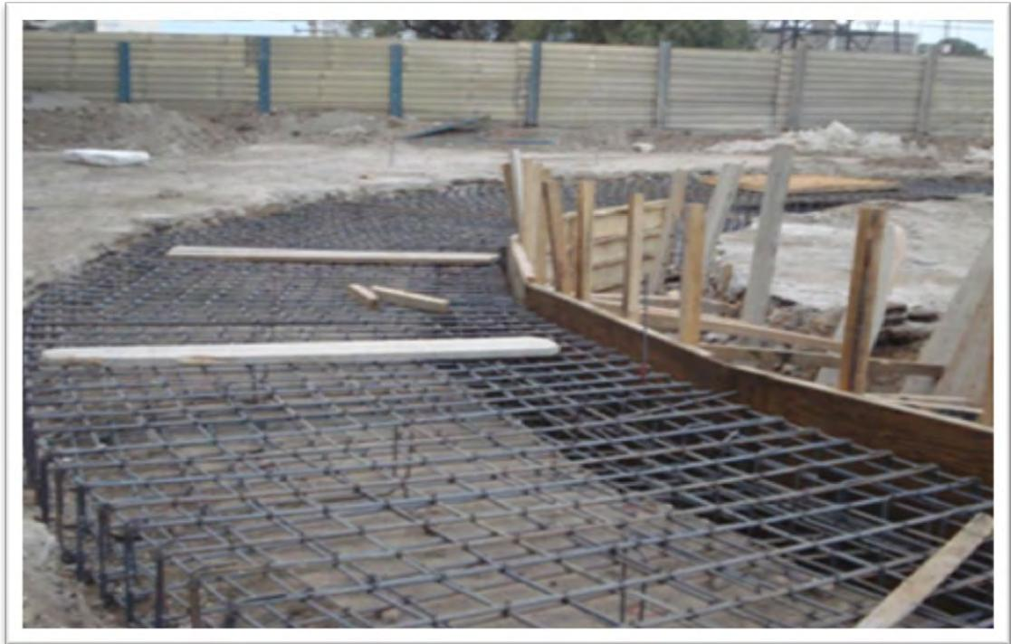
*Fig. 21 Armado de brocal exterior.*
