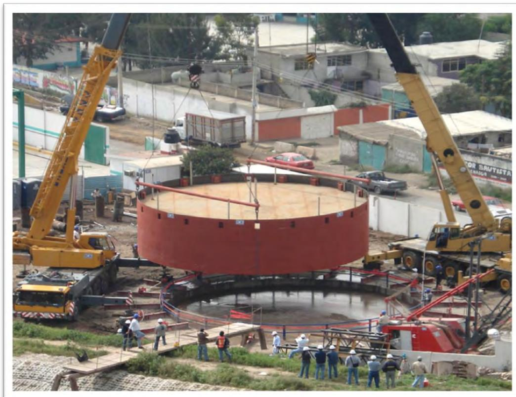
Fig. 34 Posicionamiento de tanque flotado
