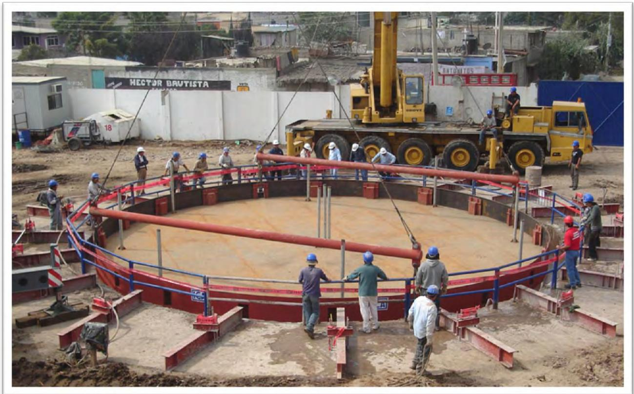
*Fig. 37 Viga de sujeción para posicionar el tanque de flotación*
