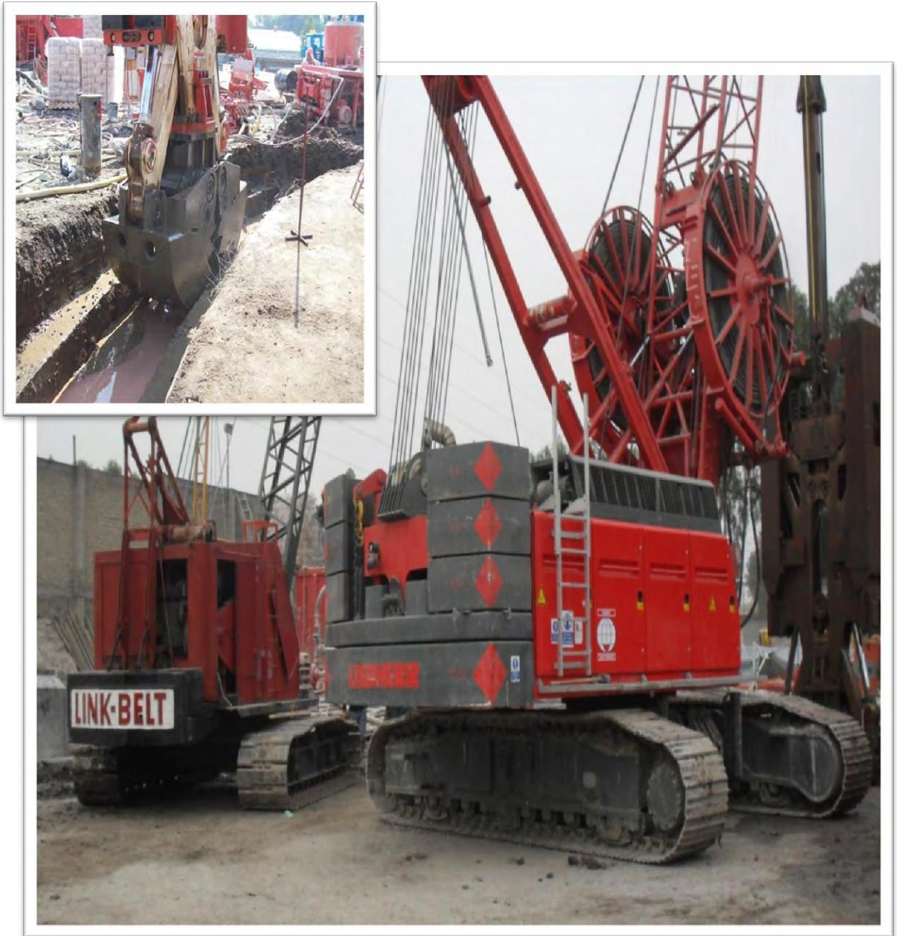
*Fig. 30 Grúa Liebherr 855 HD y Almeja Hidráulica*
