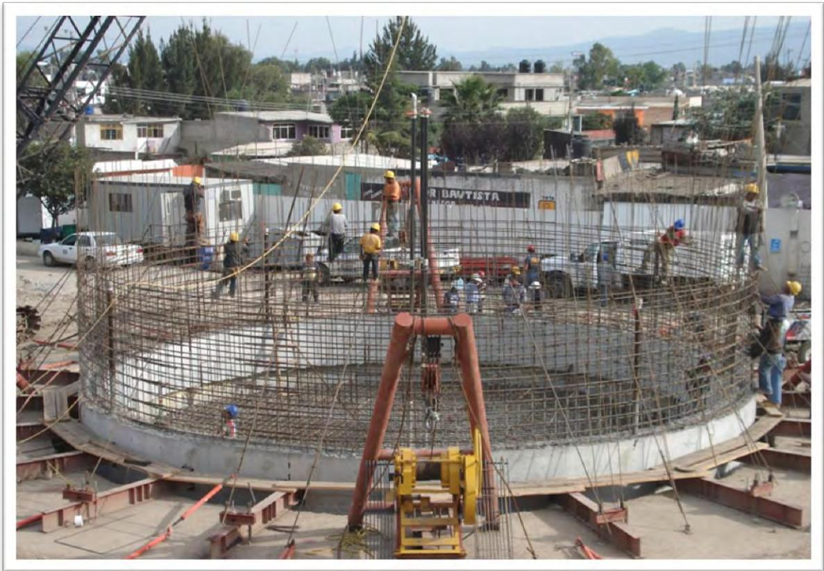
*Fig. 41 Armado de muro de lumbrera*
