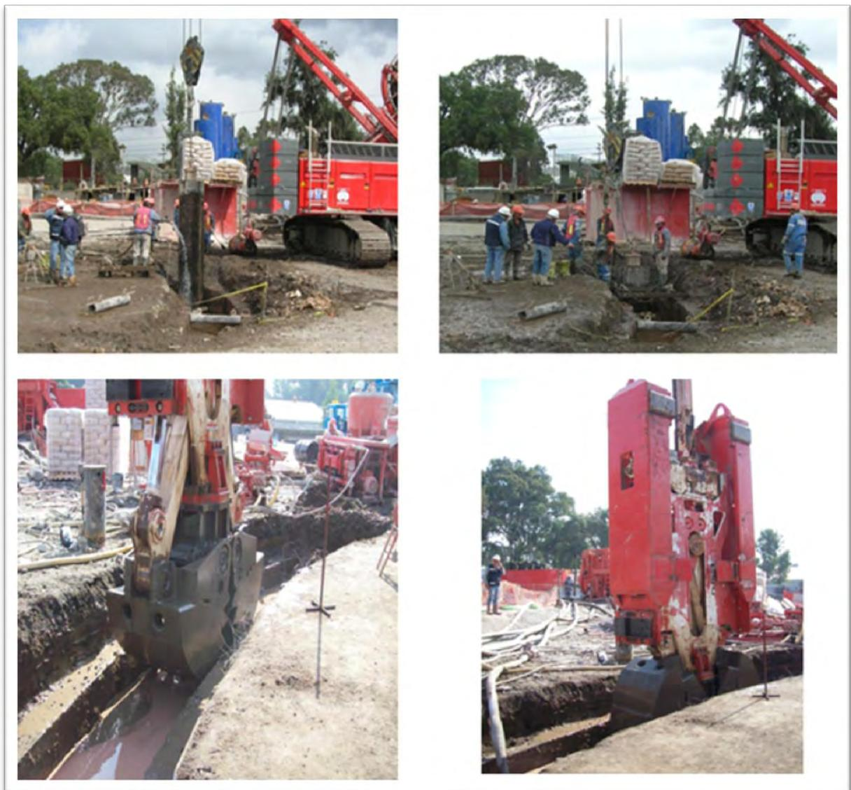
Fig. 24 Excavación Muro Primario
