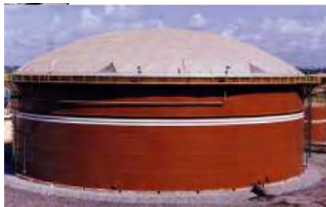
Figura A.15 Tanque de techo flotante para almacenar petróleo.
