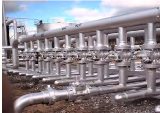
Figura A.3 Cabezal de recolección de la producción de varios pozos.
