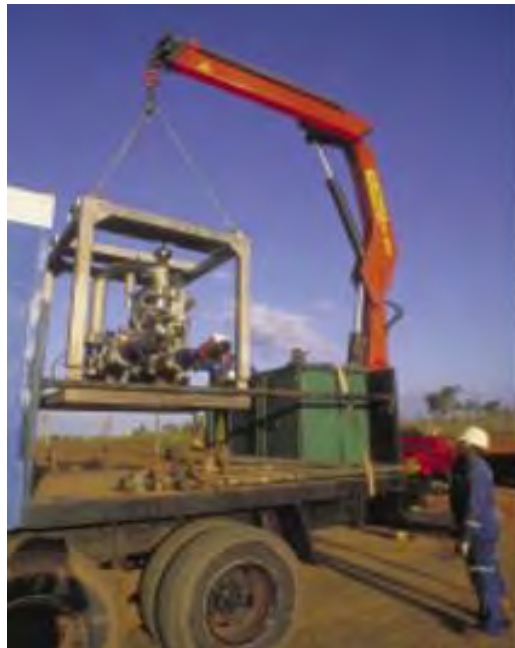
Figura II.19 Transporte de un medidor Vortex.
