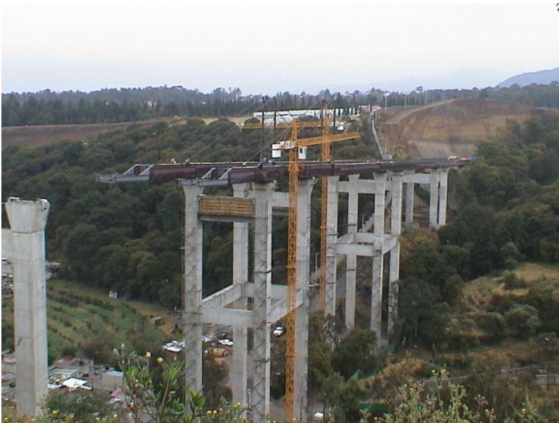
Sistema de lanzamiento por incrementos sucesivos - Puente Cañada de los Helechos.
