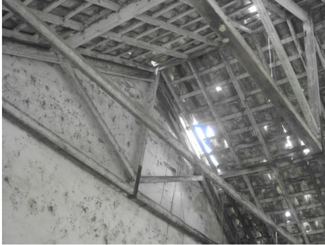
Sistema estructural a base de armaduras de madera
