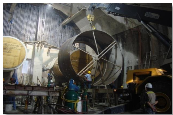
Colocación del dissipador de energía del margen izquierda (CFE La Yesca, 2013). 3 de marzo de 2012
