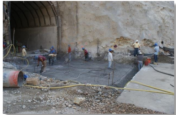
Plantilla del canal de la estructura terminal (CFE La Yesca, 2013). 31 de enero de 2013
