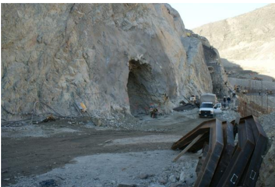
Preparativos para la colocación de marcos metálicos del túnel de entrada del desagüe aguas arriba (CFE La Yesca, 2013). 27 de febrero de 2010
