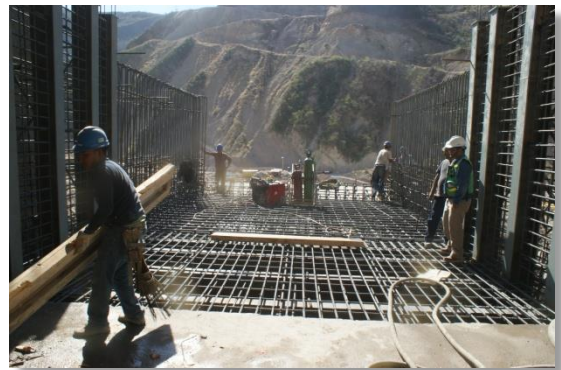
Armado de acero para la estructura terminal del desagüe de fondo con sus respectivos reflectores plantilla y laterales (CFE La Yesca, 2013). 5 de febrero de 2013
