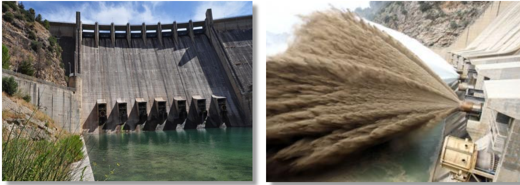
Figura No. 7 Desagüe de fondo de la Presa Iznájar (Internet navegador Google/imagen, 2012).
