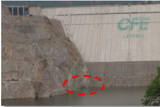
Llenado del embalse, a punto de cubrir la rejilla de la bocatoma (CFE La Yesca, 2013). 30 de junio de 2012
