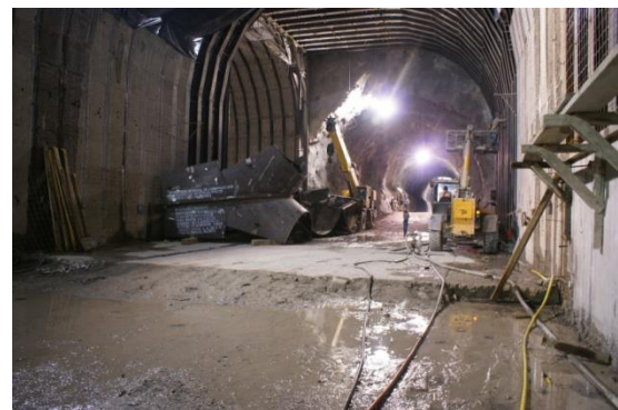
Preparación para la zona de la bifurcación y acabados de detalles de los marcos metálicos (CFE La Yesca, 2013). 31 de mayo de 2011
