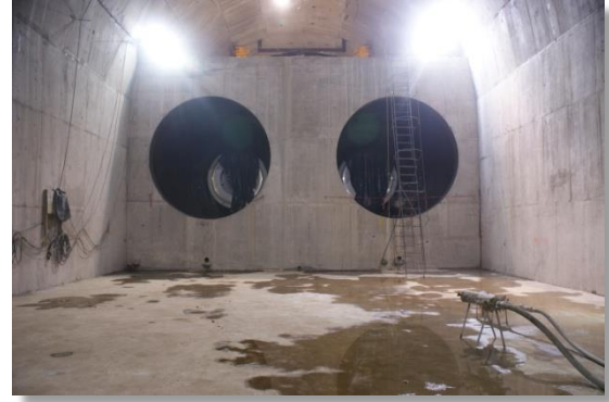
Termino de los disipadores de energía y en el interior se observa las válvulas de chorro (CFE La Yesca, 2013). 31 de mayo de 2012
