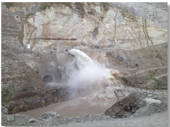
Prueba del desagüe de fondo (CFE La Yesca, 2013). 08 de marzo de 2013
