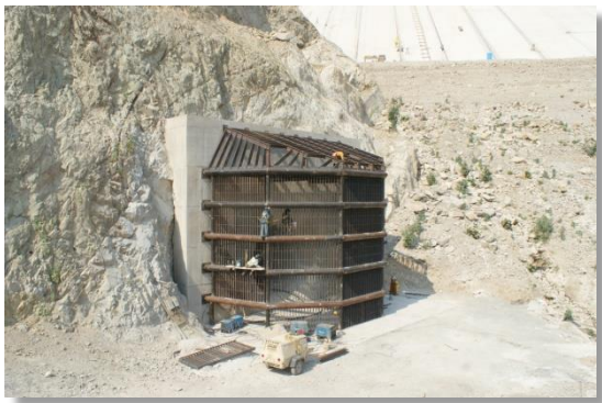
Últimos detalles de la construcción de la rejilla de la bocatoma (CFE La Yesca, 2013). 5 de mayo de 2012
