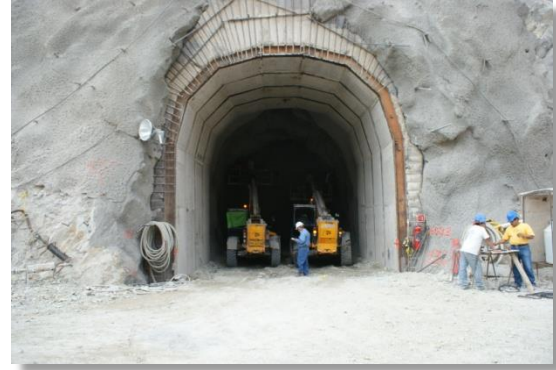
Termino de la colocación de marcos metálicos en el túnel de entrada en aguas arriba (CFE La Yesca, 2013). 15 de marzo de 2010
