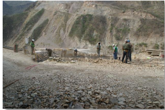
Construcción del camino de rodamiento al final de la estructura terminal, aguas abajo (CFE La Yesca, 2013). 23 de enero de 2013
