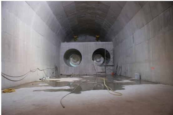
Acabado de los disipadores de energía y zona de transición (CFE La Yesca, 2013). 2 de enero de 2013
