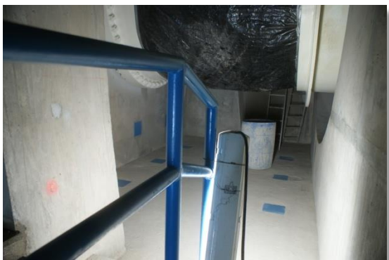
Acabado de la zona de retorno del agua entre las cámaras y muro separador (CFE La Yesca, 2013). 2 de enero de 2013
