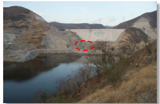
Llenado del embalse, cubriendo los túneles de desvió (CFE La Yesca, 2013). 15 de junio de 2012
