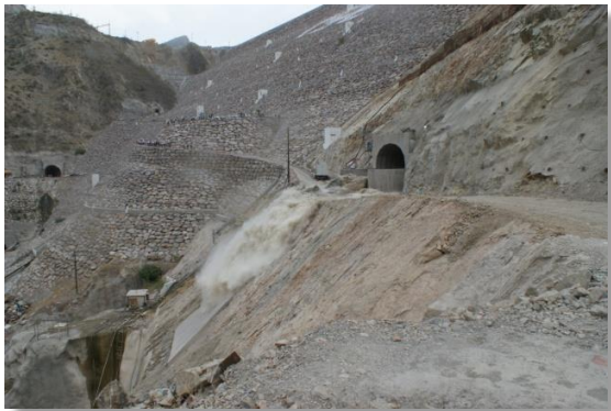
Prueba del desagüe de fondo (CFE La Yesca, 2013). 08 de marzo de 2013
