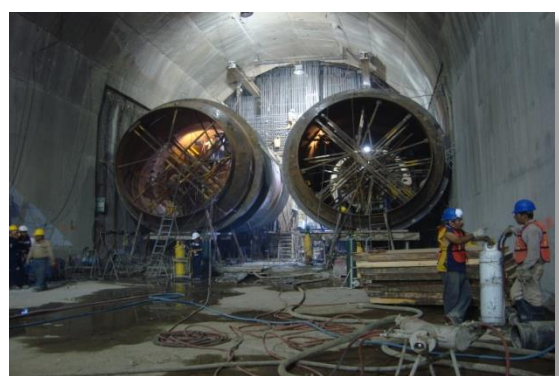
Término de los dissipadores de energía, haciendo los últimos acabos (CFE La Yesca, 2013). 13 de marzo de 2012
