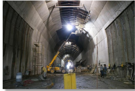
Recubrimiento de concreto de los marcos de metálicos de la zona de transición y túnel de salida (CFE La Yesca, 2013). 30 de septiembre de 2011
