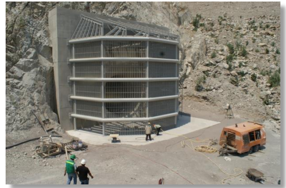
Aplicación de recubrimiento a la rejilla de la bocatoma (CFE La Yesca, 2013). 31 de mayo de 2012
