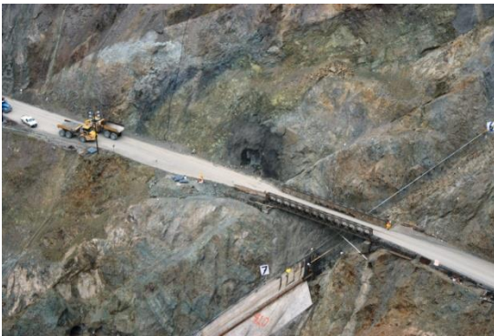
Tratamiento para el soporte y estabilización del talud de entrada (CFE La Yesca, 2013). 3 de febrero de 2010
