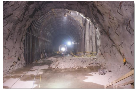
Anclajes en muros y bóveda en la zona de bifurcación; colocación de marcos metálicos en zona de válvulas, caseta de control y zona de transición (CFE La Yesca, 2013). 30 de abril de 2011
