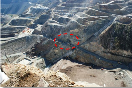
Localización del desagüe de fondo (CFE La Yesca, 2013). 1 de febrero de 2010
