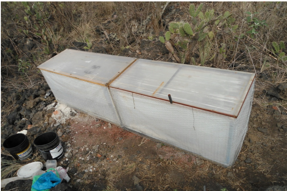
Figura "C" ; Instalación que protege a los sistemas de la intemperie
