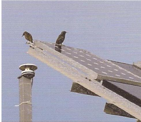
*Fig. 3.1 Los paneles solares suelen ser uno de los sitios escogidos por la aves para posarse, provocando sombras y suciedad.*
