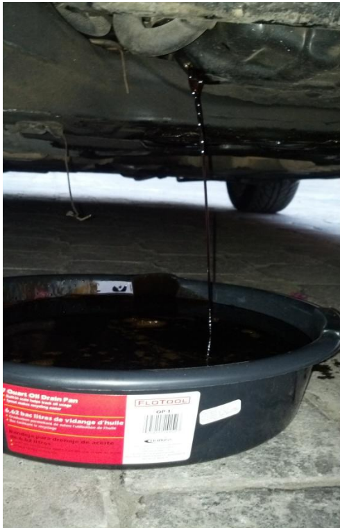
(Imagen 4.3 – Drenado de aceite del motor de Nissan 350Z)
