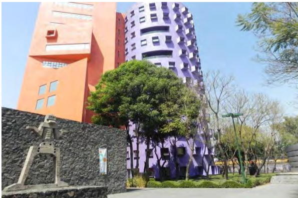
Torre administrativa con oficinas para los profesores investigadores en el Centro Nacional de las Artes, de Legorreta Arquitectos.
