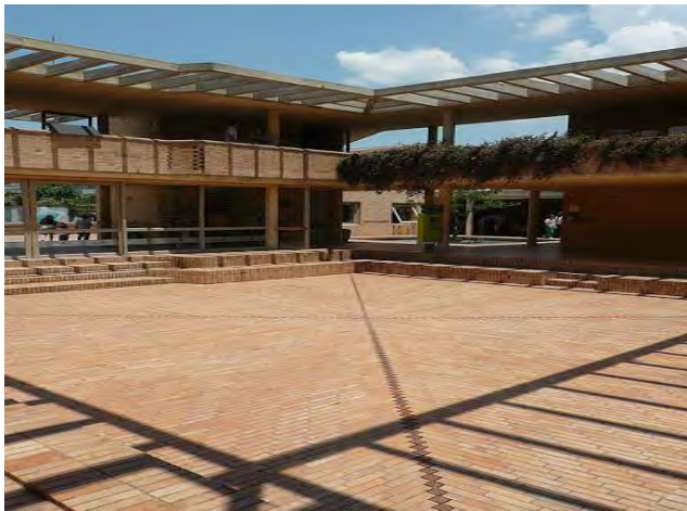
Patio central que sirve para proporcionar iluminación y ventilación a los locales en planta baja y primer nivel.
