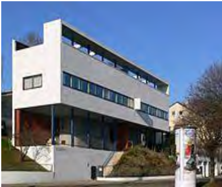
La casa de Le Corbusier construida para la exposición Weissenhofsiedlung en Stuttgart, observamos la aplicación de la ventana longitudinal y la fachada libre.
