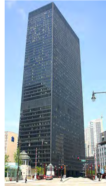
Edificio IBM, Chicago, Estados Unidos, Mies Van der Rohe.
