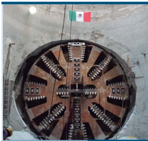
Vista frontal de salida de tuneledora.
