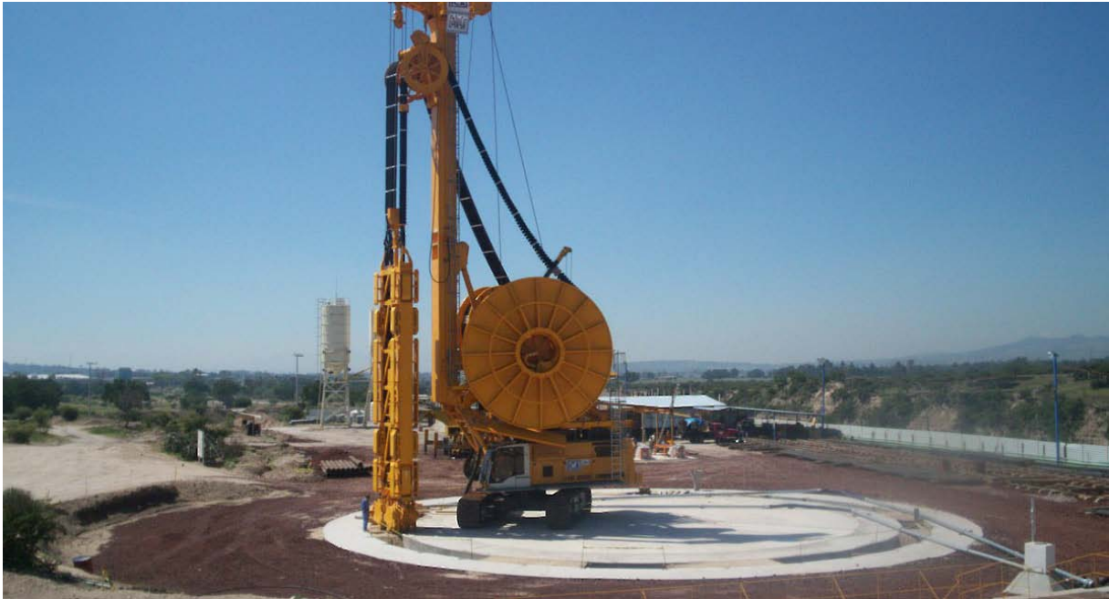
Lumbrera 20 excavación para muro milán con hidrofresa.
