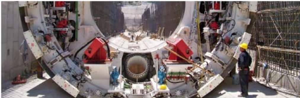
Vista frontal del ensamble de uno de los segmentos de tuneledora.
