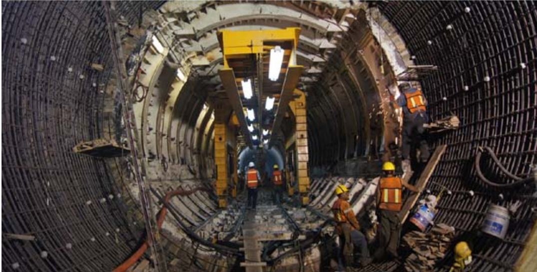
Vista del armado de acero de refuerzo y preparación de cimbrado para colado del revestimiento definitivo.
