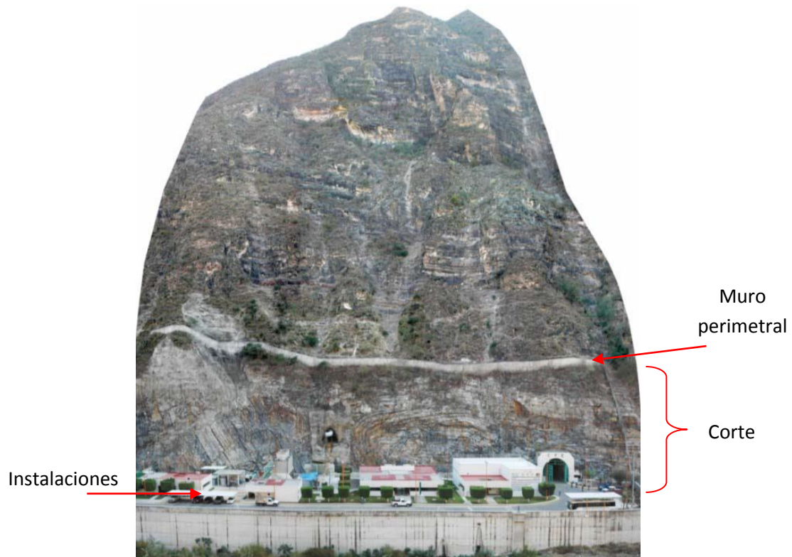
Figura 6.2 Fotografía frontal de la ladera e instalaciones anexas a la casa de máquinas, (Montiel E. et al., 2012).
