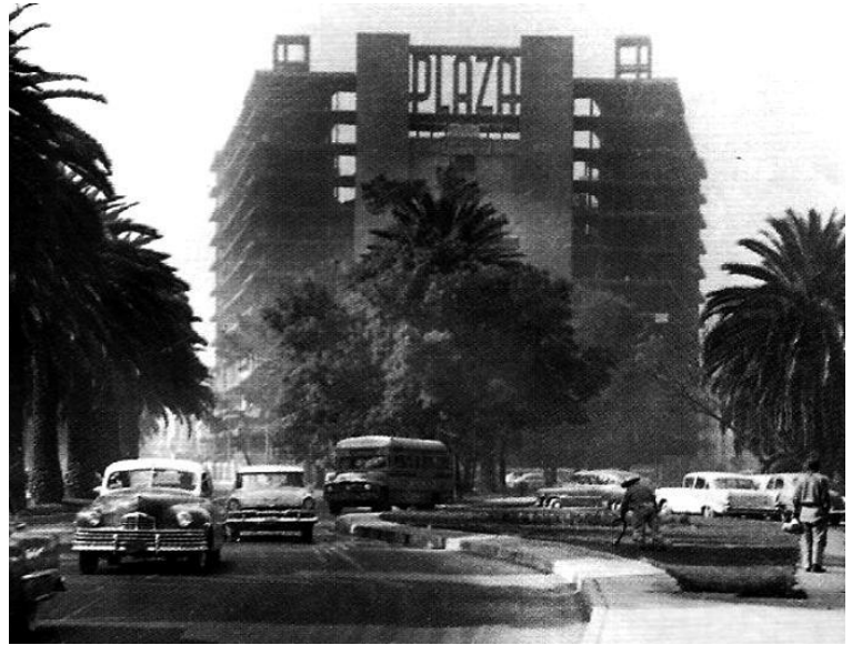
Fig. 2.5. El Plaza Condesa en construcción, ca. 1946
