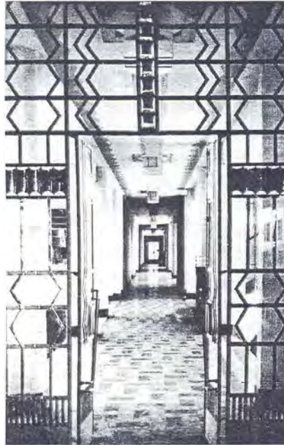
Fig. 1.10. Vestíbulo del Edificio Jardín- Martí-Haghembeck. 1931
