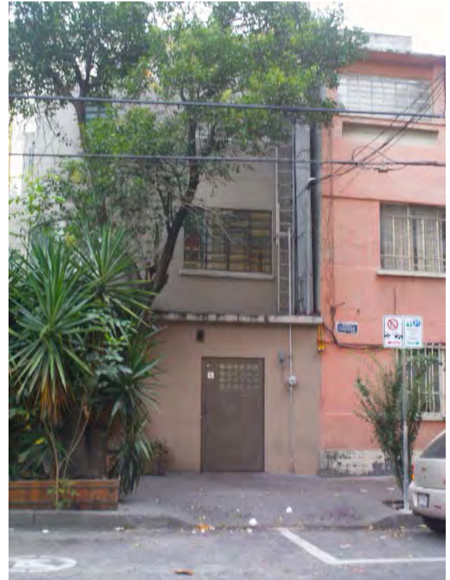
Fig. 3.4. Las rejas que constituían la cochera fueron reemplazadas por muros. Se aprecia también la chimenea de la cocina que corre hasta el último nivel del edificio.
