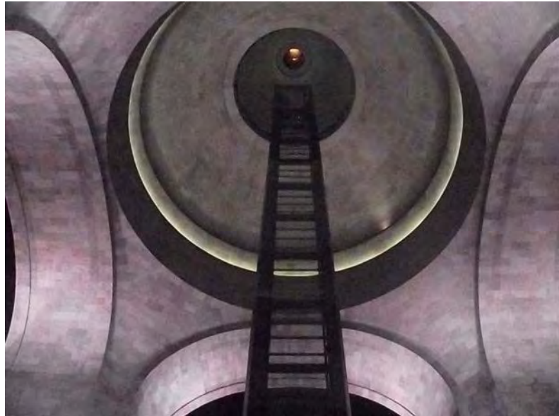
Fig. 1.4. Vista inferior del Monumento a la Revolución, una de las construcciones pertenecientes al art déco más conocidas de México.
