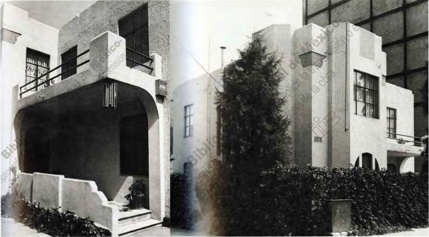
Fig. 3.8. Aspecto original del frente de la casa.
