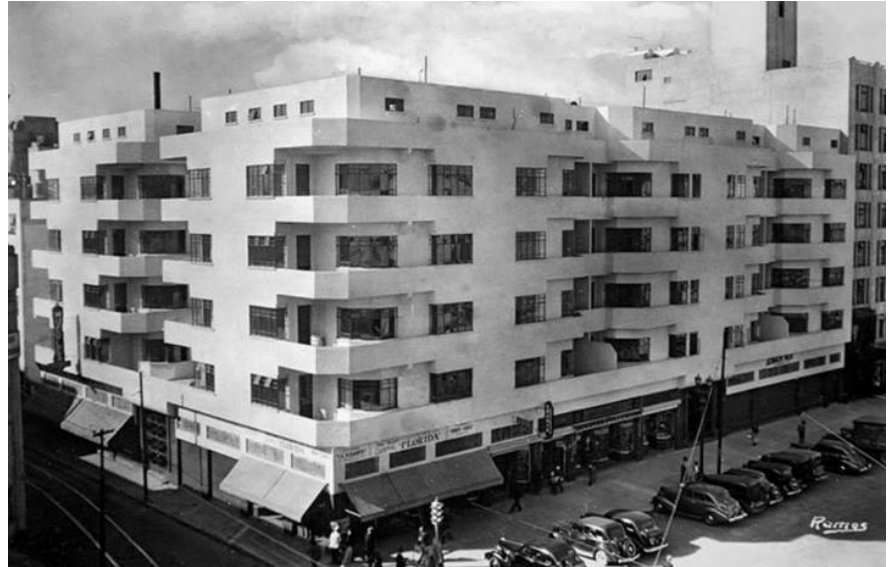
Fig. C. 3. Edificio art decó desaparecido tras el sismo de 1985, ubicado en el cruce de Victoria y Eje Central.
