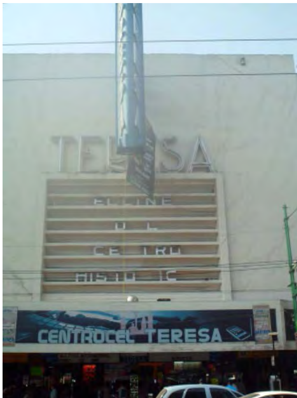
Fig. 2.8. El Cine Teresa en 2013. Se aprecia un evidente deterioro en todo el edificio, cosa que refleja también el descuido de sus propietarios.
