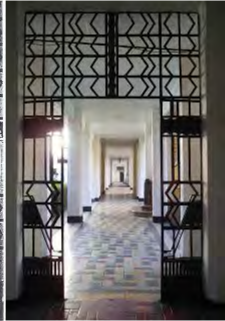
Fig. 1.11. Vestíbulo del Edificio Jardín- Martí- Haghembeck, 2012
