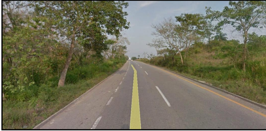
Figura 2.3.7 Bordillos en la carretera Coatzacoalcos-Villahermosa
