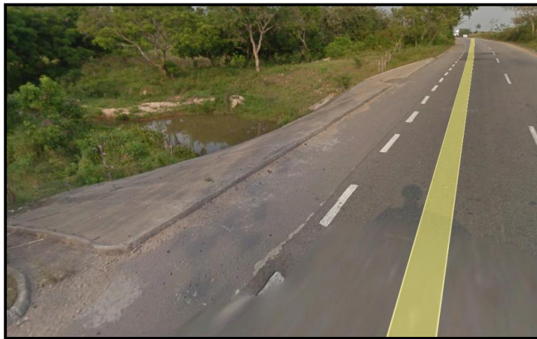
Figura 2.3.1 Losa de 6.00 x 3.00 m en la estación 37+138.65 del cuerpo A.
