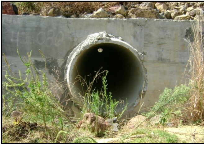
Figura 2.2.5 Salida de tubo de concreto de 0.90 m de \Phi empotrada en cabezote
