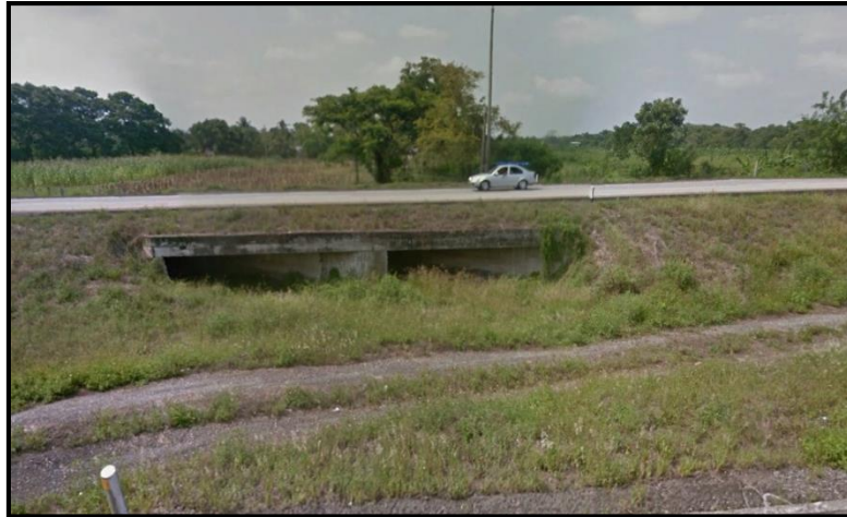
Figura 2.3.4 Losa doble de concreto de 6.00 x 2.00 m en la estación 52 +591.88
