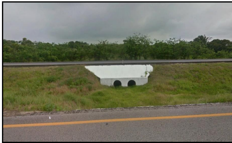
Figura 2.3.5 2 tubos de concreto de 1.50 m de \Phi en la estación 53+151.93
