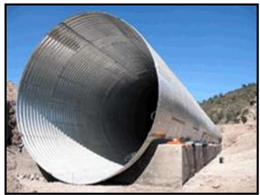
Figura 2.2.2 Alcantarilla de Lámina
