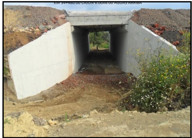
Figura 2.2.8 Cajón de concreto de 6.00 x 6.00 m
