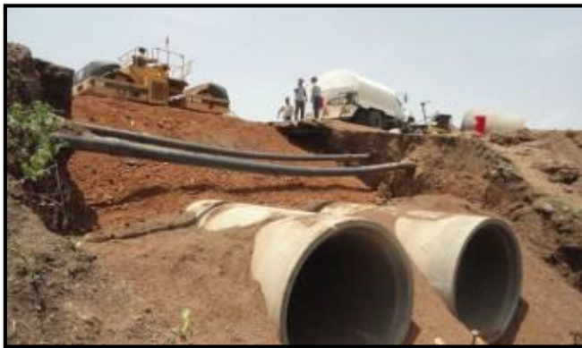
Figura 2.2.3 Alcantarilla tubular de concreto
