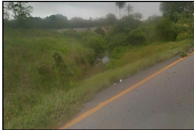
Figura 2.3.2 Losa de 6.00 x 3.00 m en la estación 37+249.93
