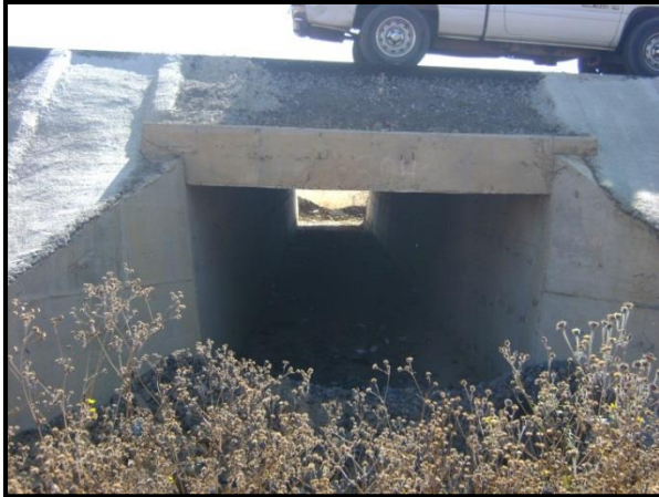
Figura 2.2.9 Losa de drenaje
