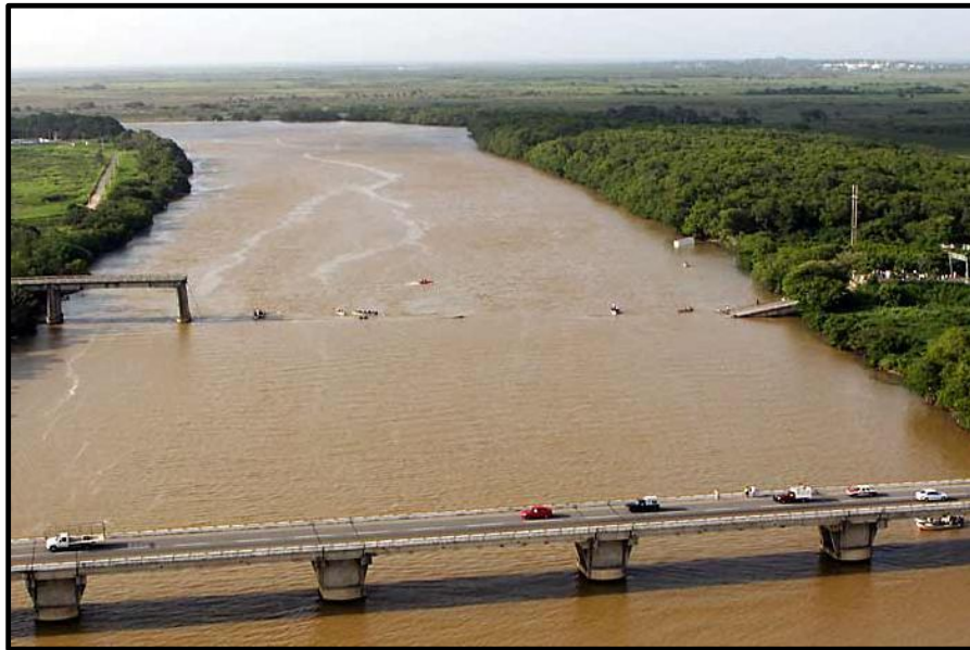
Figura 5.5.3 Colapso del puente Tonalá I, en donde se aprecia el tipo de apoyo.
