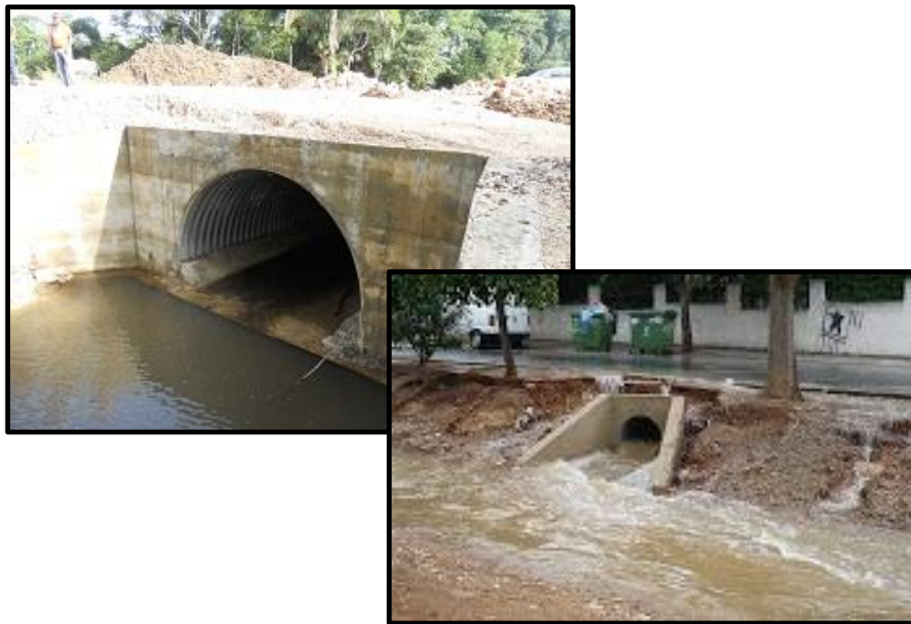
Figura 2.2.11 Ejemplo de alcantarillas funcionando a superficie libre
