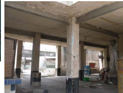
COLUMNAS Y TRABES DE ACERO
