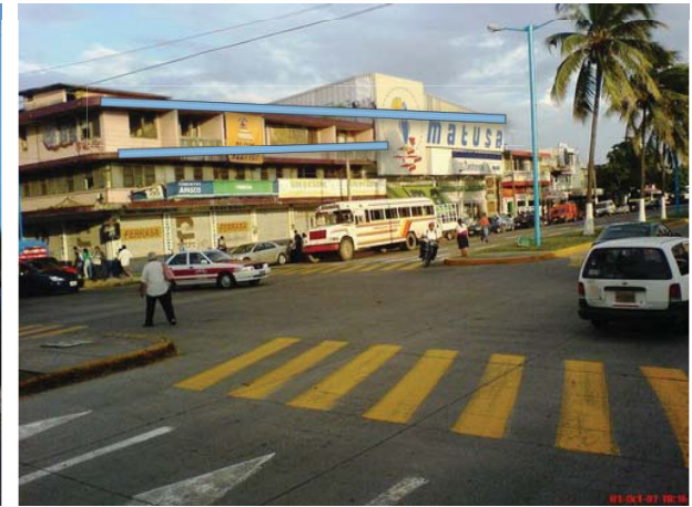
AV. IGNACIO ALLENDE: Construcciones de 2 y asta 3 niveles como máximo
