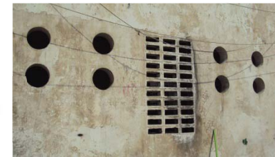
Penetración de soleamiento controlada
