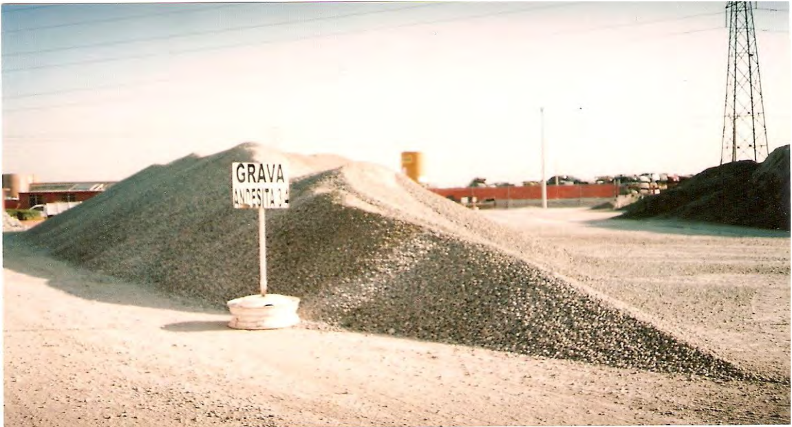
Figura 2.10. Se observa la colocación de letreros para identificar el material y la separación de los mismos.
