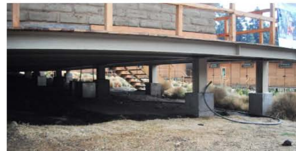
Imagen 4.9: Detalle de la parte inferior de la estructura de los locales comerciales donde se puede ver la cimentación.
