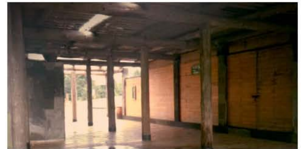
Imagen 4.13: Vista del pergolado de acceso en temporada bajadonde debe de ser protegida ya ue no fue bien tratada. Para proyectos públicos se debe tomar en cuenta el mantenimiento que sea sencillo y no tener que trabajar con el los 6 meses e que este cerrado el santuario.
