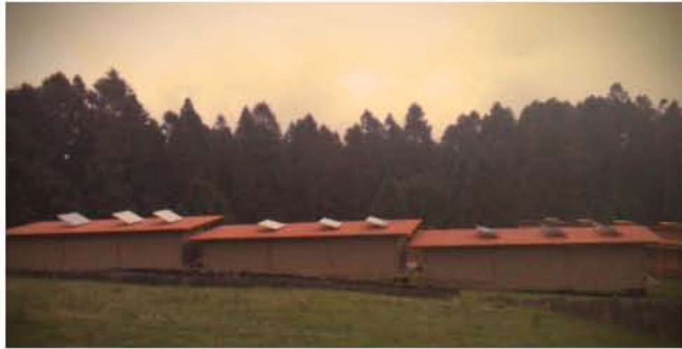
Imagen 4.10: Los paneles fotovoltaicos deben de tener una estructura extra porque al no estar bien orientados los edificios la luz no es aprovechada al máximo. Siendo realmente críticos al ser un Santuario Público no se requiere electricidad ya que los horarios de atención son de 9:00 a 16:00hrs mismas que cuentan con iluminación natural.
