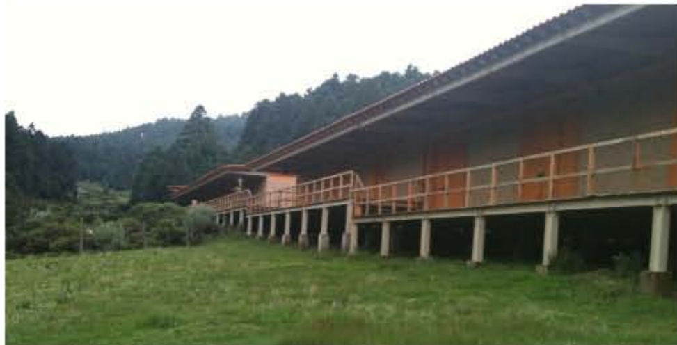
Imagen 4.6: Vista posterior de los locales de comida donde se puede observar el desnivel del terreno y como las edificaciones no fueron diseñadas adecuadamente.
