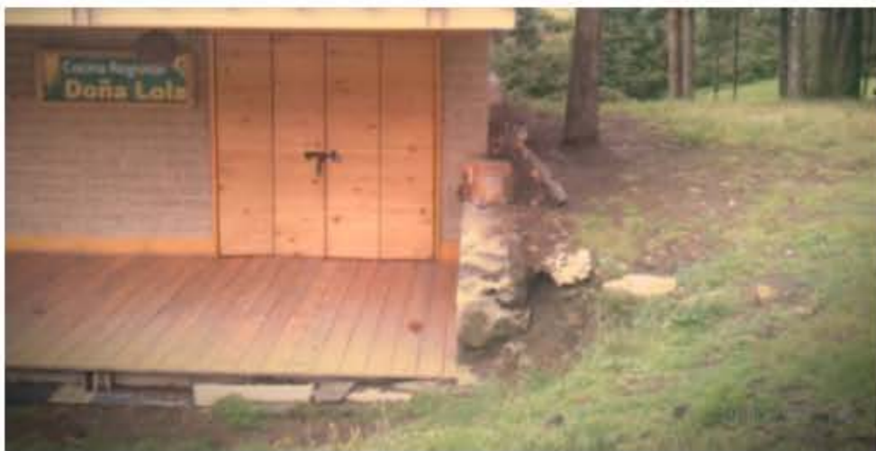
Imagen 4.7: Muro de contención al inicio de este bloque de locales.
