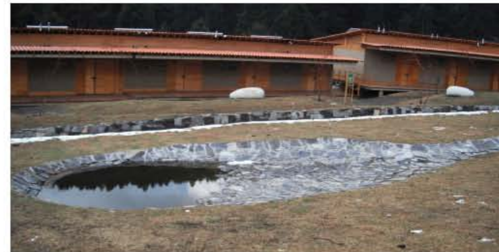
Imagen 4.8: Acercamiento al recolector de agua pluvial dentro del conjunto. Donde no hay una cisterna para almacenarla y ocuparlo en los baños o en otras actividades.
