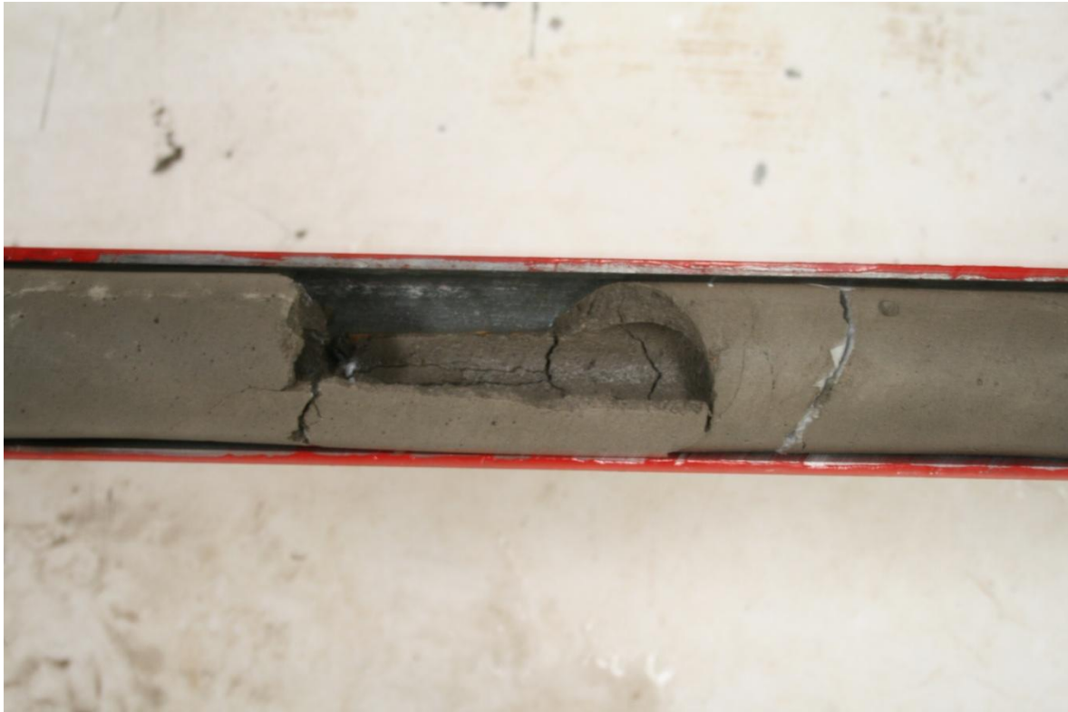
Figura 5.23 Falla del tubo, vista en planta
