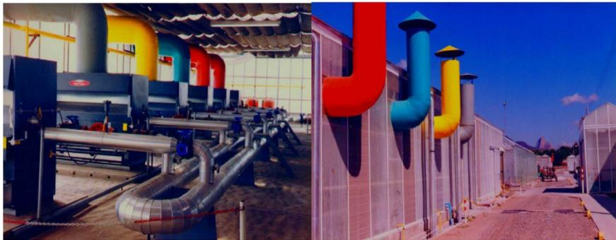
Figura 2: Sistema de Caldera para controlar la temperatura de ambiente y del agua de cada invernadero [18]
