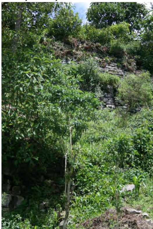
Imagen 6. Muro de contención en Tepantipak.
