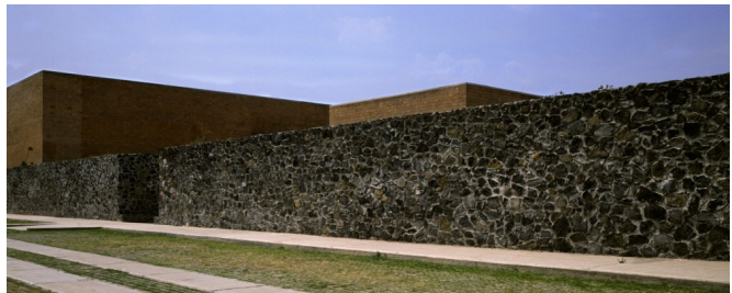
Vista exterior del edificio. (Muro de piedra)
