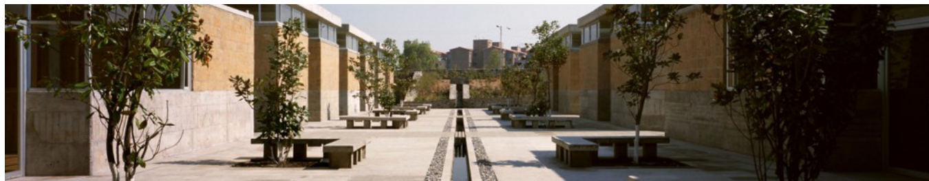
Edificio para personas invidentes, proyectado por el Arq. Mauricio Rocha.
