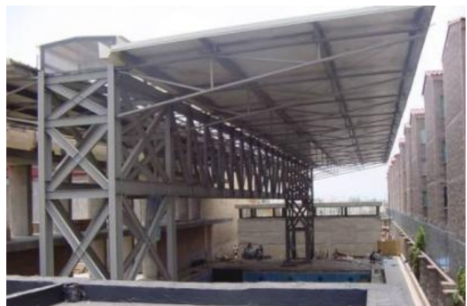
Cubierta del área de la Piscina (Armadura de acero).
