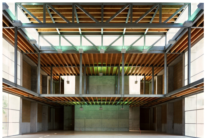
Cubierta del área de la Piscina (Armadura de acero).
