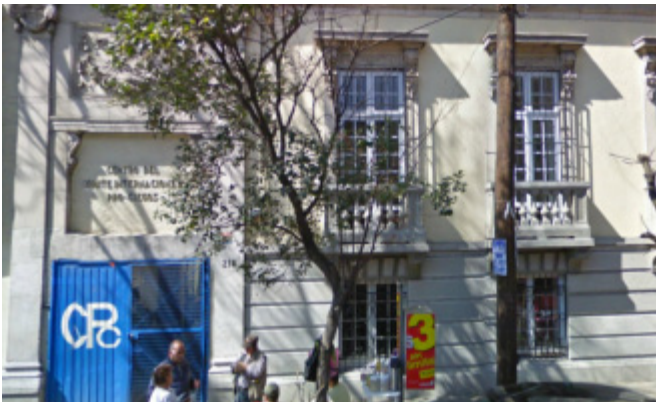
Fachada del edificio Pro-CIEGOS
