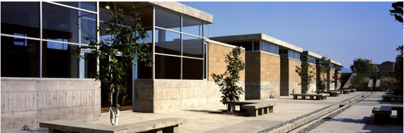
Vista interior, donde se muestra la Biblioteca a un costado y las aulas al fondo de la imagen.
