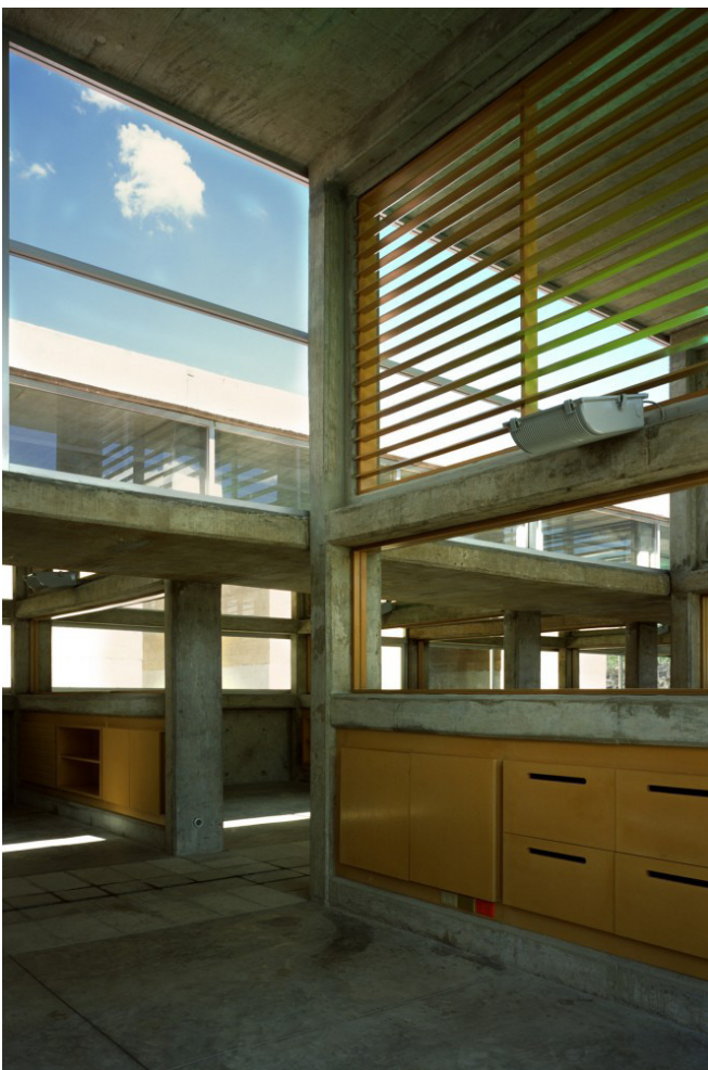
Vista interior Biblioteca (Vigas y columnas de concreto armado)
