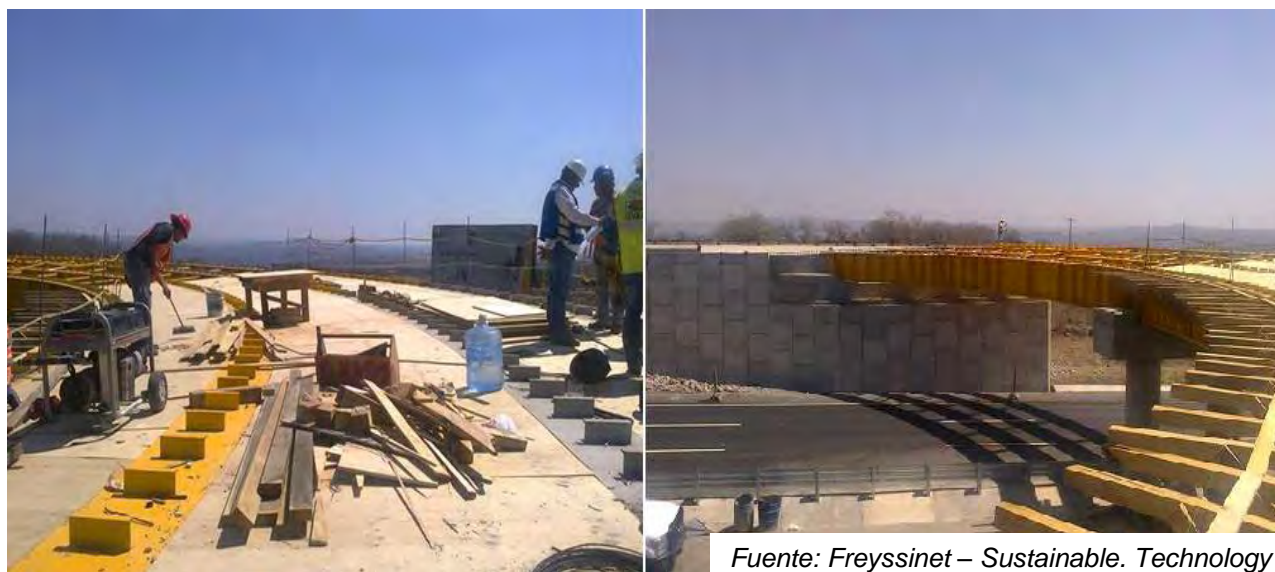
Figura 5.21. Colado de la losa.
