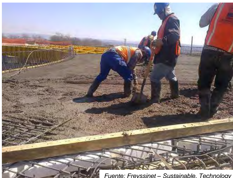
Figura 5.21. Colado de la losa.
