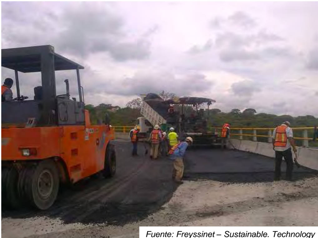
Figura 5.22. Carpeta asfáltica del puente.
