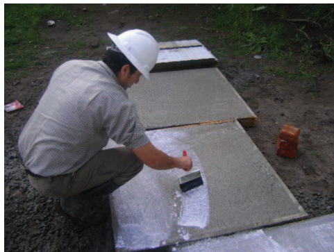
Vista de muestras después de colocacion de concreto.
