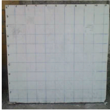
Muestra No. 3 con refuerzo de polietileno sin fisuras.
