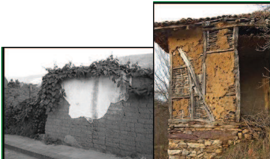
Fotografías de Casas realizadas con material de adobe
