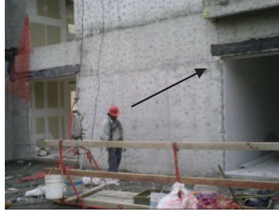
Trabajos de colocación de impermeabilizante en juntas.
