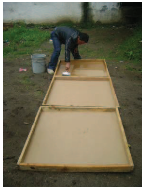
Colocación de desmoldante en cimbra.
