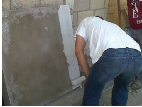
Colocación de pintura de agua con cal, 3ra. Muestra
