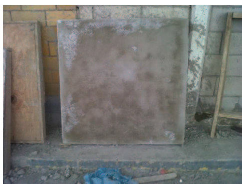
Segunda capa de cemento – arena 3ra. Muestra de aplanados reforzada con malla de fibra de vidrio.
