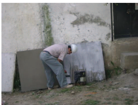
Colocación de pintura a base de agua con cal. 2da. Muestra
