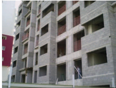
Imagen de terminación de col. De muros de block que dan hacia la fachada.
