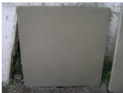
Segunda capa de cemento – arena 1ra. Muestra de aplanado sin refuerzo.
