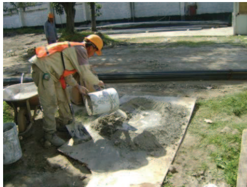
Colocación de agua en la mezcla para trabajos de zampeo.
