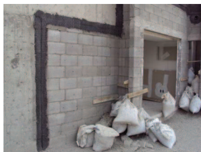
Colocación de malla tela de gallinero sobre superficie de fachada.
