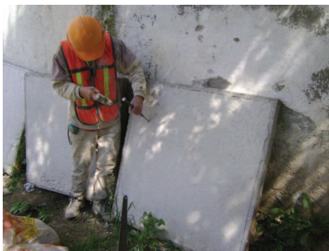
Se procedió a realizar el escarificado de la Muestra 1.
