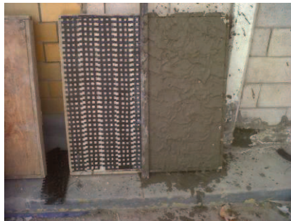
Colocación de la malla de fibra de vidrio., muestra No.3
