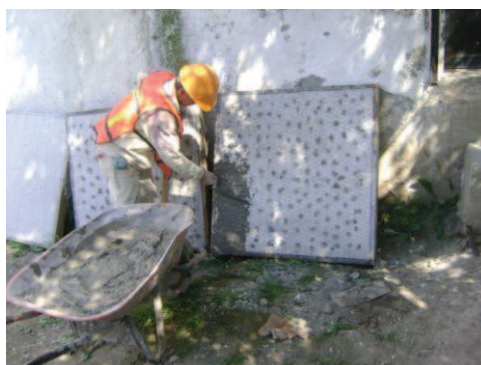
Colocación de zampeo.
