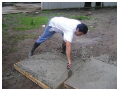
Colocación del concreto en las bases de madera.
