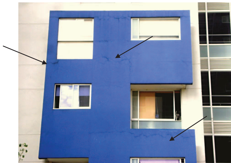
Fotografía de edificio Bilbao fachada 4, en el cual podemos observar las fisuras horizontales.
