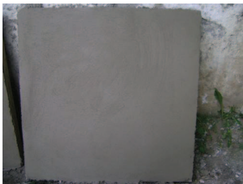
Segunda capa de cemento – arena 2da. Muestra de aplanados reforzada con malla tela de gallinero.
