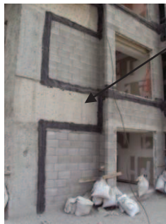
Colocación de Impermeabilizante en Juntas.
