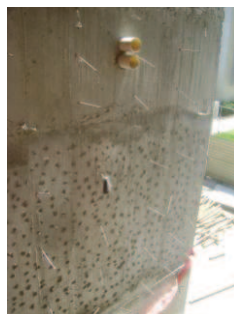
Fotografía de elementos de concreto con los trabajos de escarificado.
